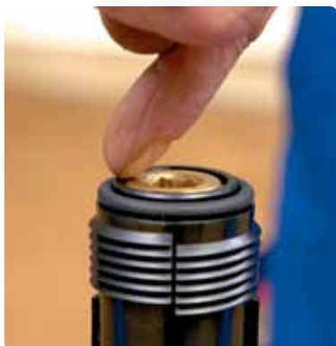
10. Når anboringskruen skrues tilbage, er det vigtigt, at den ikke skrues for langt op, da der skal være plads til at skruer beskyttelsehætten på, så den lukker tæt.
