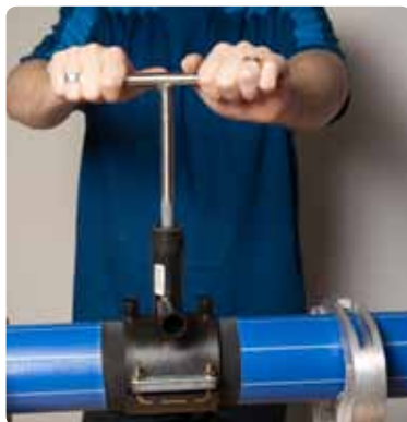
9. Efter endt svejse- og køletid kan der anbores med anboringsnøgle. Der kan anbores, imens der er tryk på røret, hvis afgreningen er koblet til eller afproppet.
