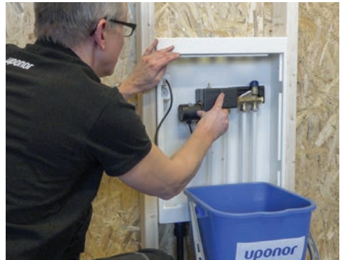
14. Montera isolersatsen för bästa energieffektivitet.
