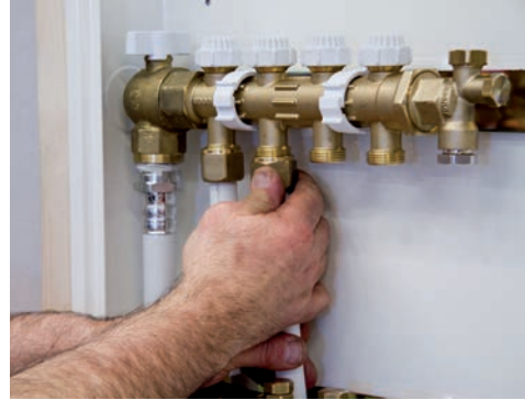
14. Skruva fast kopplingen i fördelaren.
