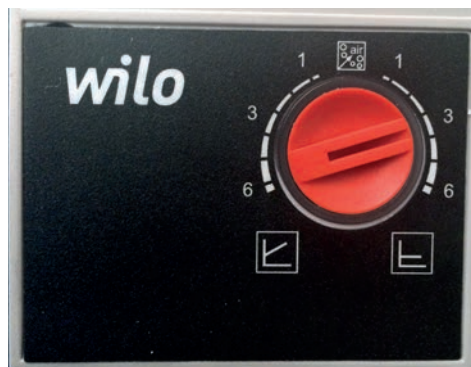
Bild: Justering av cirkulationspump
