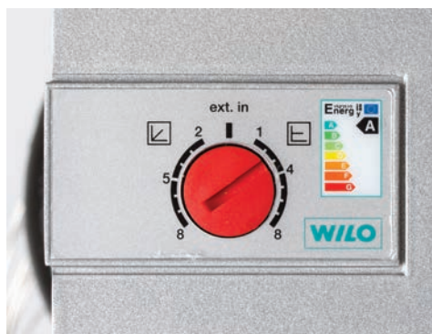
Bild: Justering av cirkulationspump
