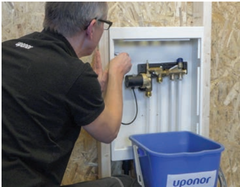
13. Anslut till nätspänning och starta värmesystemets primärpump.
