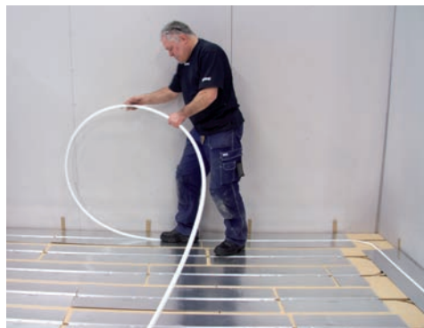
15. Trampa ner röret i plåtarna enligt slingritningen. Om du har röret i en båge framför dig underlättas monteringen.
