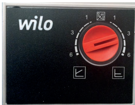
Bild: Justering av cirkulationspump
