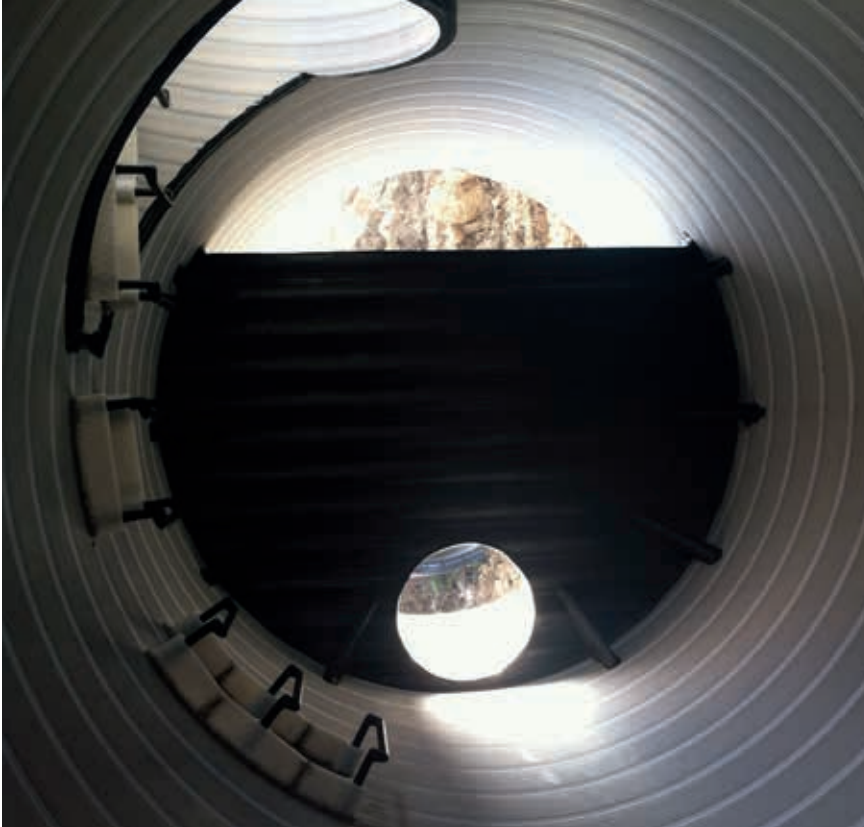
Wnętrze retencyjnego kanału ściekowego z przegrodą piętrzącą, fot. Uponor Infra Sp. z o.o.
