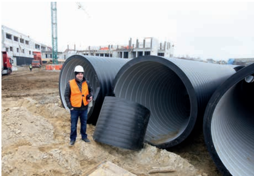
Rury PEHD Weholite wykorzystane do budowy retencyjnego kanału ściekowego na os. Krakowska-Południe w Rzeszowie, fot. Uponor Infra Sp. z o.o.
