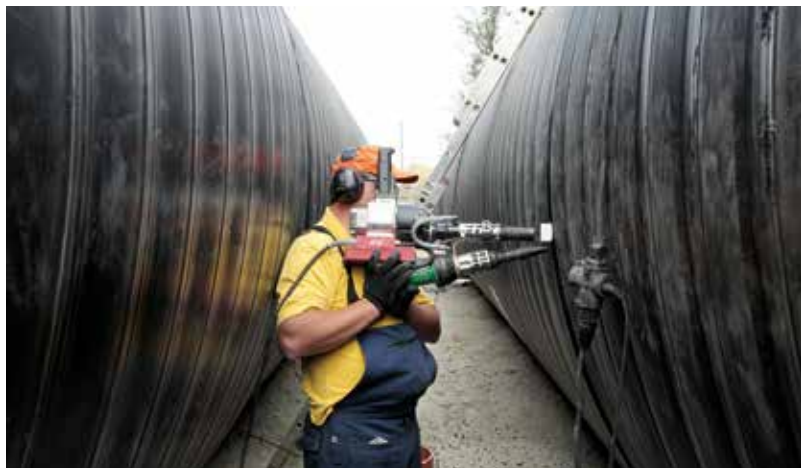
SPAWANIE EKSTRUDEREM WIELKOŚREDNICOWYCH RUR WEHOLITE ZAPEWNIĄ POŁĄCZENIE JEDNORODNE MATERIAŁOWO, MONOLITYCZNE I TRWAŁE
