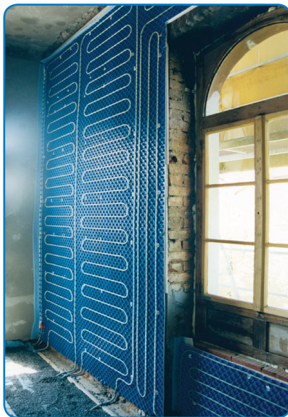
Figura I.5 Esempio di installazione di una parete radiante
