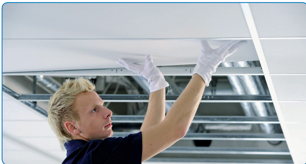
Figura 1.3 Esempio di installazione di un controsoffitto radiante
