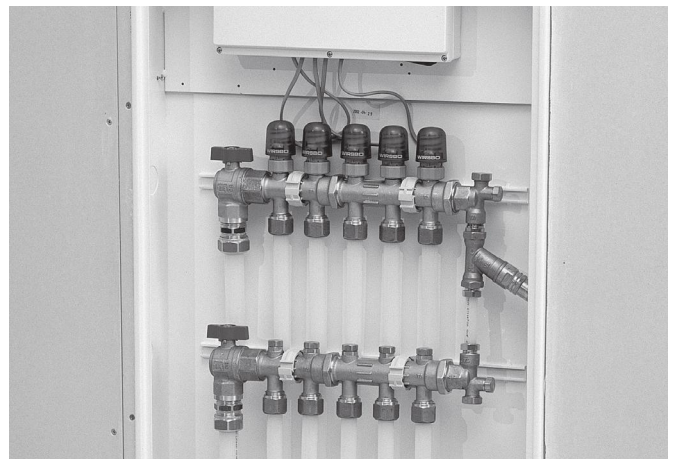
Exempel på Wirnsbo WGF fördelare (1999–idag)
