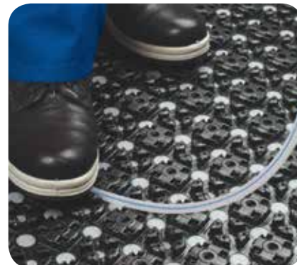
Uloženie rúrok zvláda jeden človek – úspora nákladov
