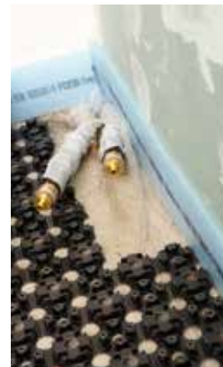
Inštalácia Uponor Minitec pásov na hranách
