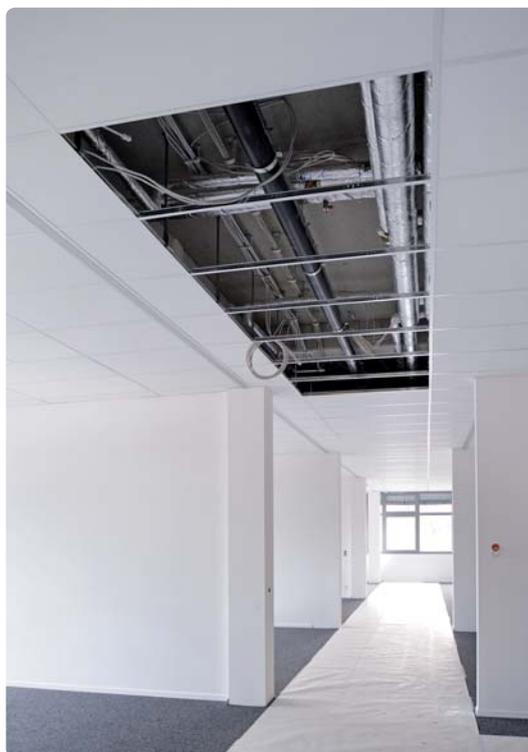
Los sistemas que deban instalarse sobre el techo deberán colocarse antes que los paneles Uponor Comfort. Cualquier elemento instalado en el techo (como las luces, los detectores de incendios, rociadores, etc.) deberá estar sujeto a la estructura de este si su peso lo requiere. Las cargas más ligeras, como los tubos halógenos, pueden instalarse directamente en los paneles acústicos.
