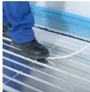
Uponor sistēmas caurules pēc tam tiek iespiestas siltumvadošo lameļu Omega gropē.
