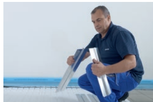
Nepieciešamības gadījumā Siccus metāla lameles var saīsināt iepriekš iespējajās vietās, neizmantojot instrumentus.
