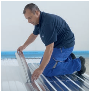
Siccus siltumvadošās lameles aprēķinātajos attālumos tiek ievietotas Siccus siltumizolācijas slāņa kanālos.
