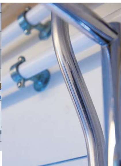
VVS installatør Klaus Møller
