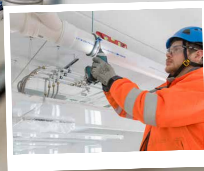
Decibel-putkia käytettiin sekä vaaka- että pystyviemäreissä.
