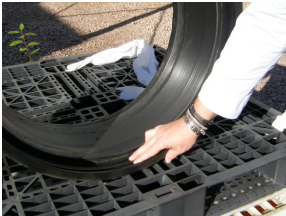
3. Smörj gummiringsspåret tunt
