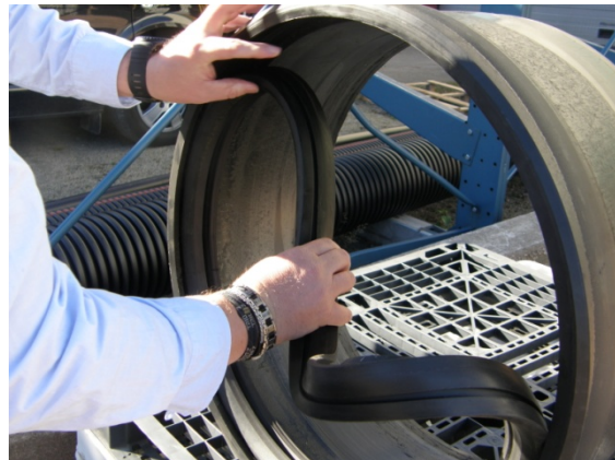
4. Montera gummiringen i spåret
