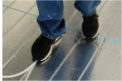
Figure 13 : Enfoncez le tuyau dans la rainure
