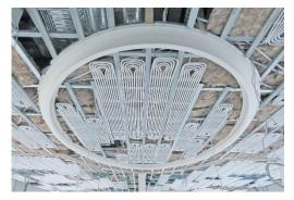
**Gestlatungsmöglichkeiten\_ThermatopM.jpg**Die fugenlose, modulare Strahlungskühldecke Uponor Thermatop M bietet vielfältige Gestaltungsmöglichkeiten: Die Bauform des wasserbasierten Systems ist flexibel, passt sich schwierigen Raumgeometrien an und bietet Freiheit bei der Raumgestaltung.
