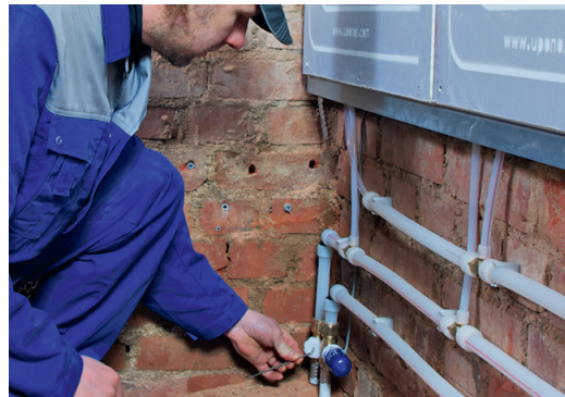
Példa: Falra szerelt Uponor Renovis panelek bekötése. Egyhelyiséges szabályozás szobatermosztáttal.
