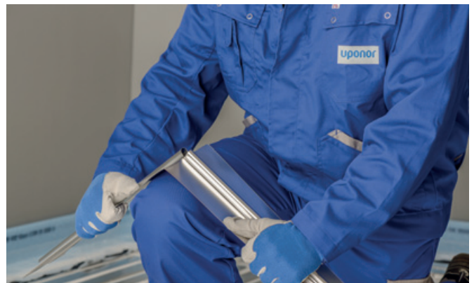
Razdelitev plošče za prenos toplote z enostavnim krivljenjem
