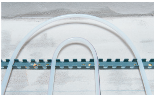
Integrirane PE-Xa cevi dimenzije 9,9 mm v sloju ometa na stenah in stropovih
