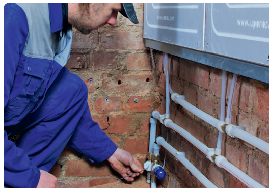
Пример: Свързване на панели Uponor Renovis, монтирани на стената. Управление на една стая чрез стаен термостат.
