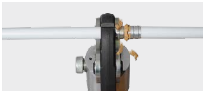
Zaustavni prsten odlomi se od prešane čahure u postupku prešanja do dužine od 32 mm.
