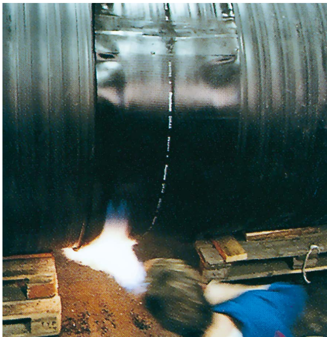
Putken tiivistys kutistenauhalla
