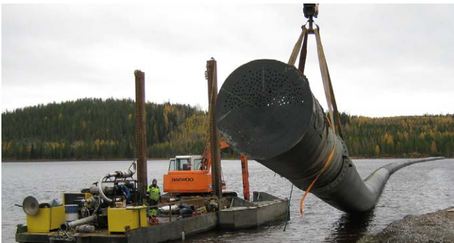
Talvivaaran kaivos, Sotkamo: Uponor Infra upotti raakaveden ottoa varten 250 m pitkän Weholite DN/ID 1600 mm imu-putken.
