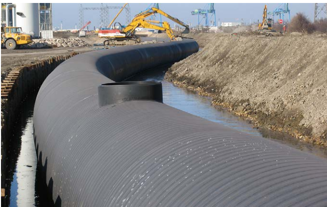
Fos-sur-Mer, Ranska: Weholite on yksi maailman harvoista PE-putkista, jota valmistetaan yli DN/ID 2000 mm kokoisena.
