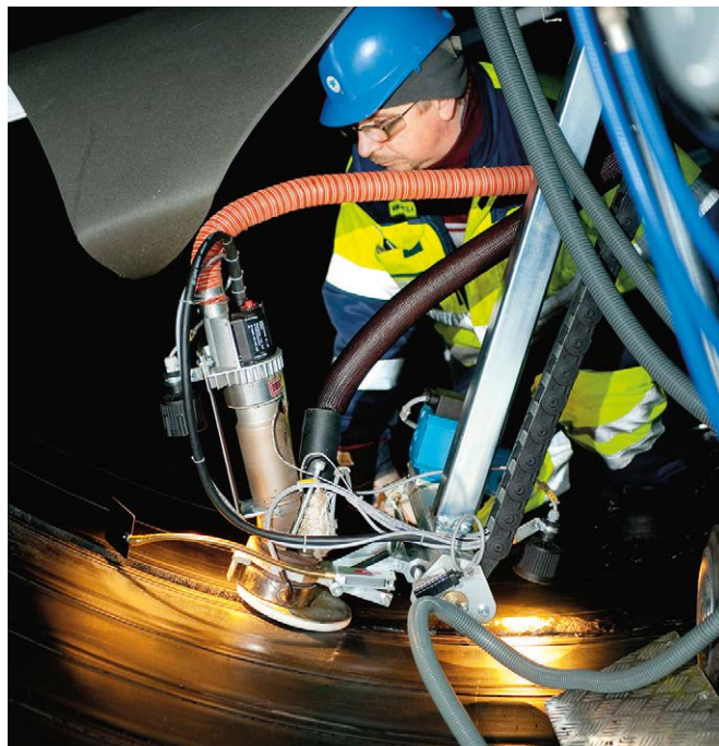
Sisäpuolinen ekstruusioidhitauskone. Kaikki hitsaustyöt edellyttävät ammatillista pätevyyttä.
