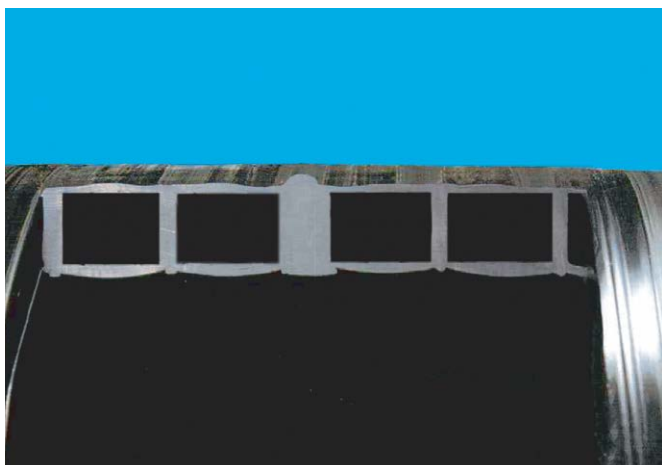
Putkiprofiilin läpihitsattu sauma
