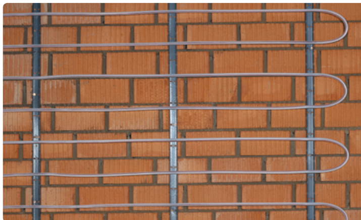
Uponor sistem stenskega ogrevanja z mokro vgradnjo
