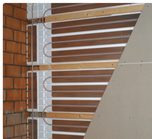
Vgradnja stenskega ogrevanja Uponor Siccus s suhomontažnimi paneli
