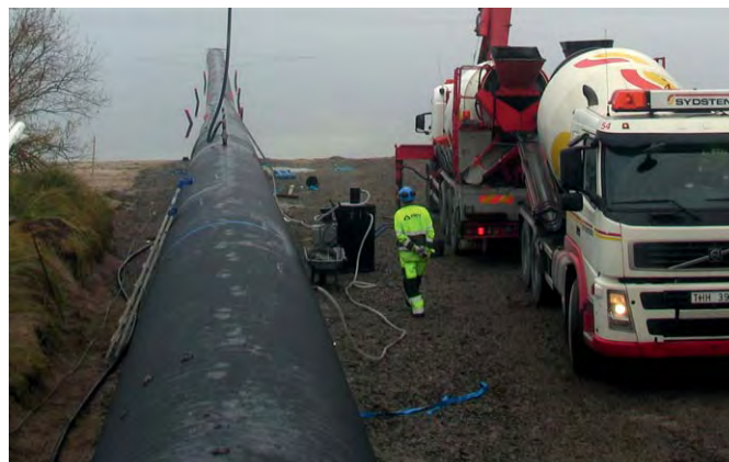
▼ Vomb: den 235 m långa Weholite DN/ID 1400 mm intagsledningen installerad i Vombsjön, Skåne för att ta in råvatten till Sydvattnens vattenverk. Genom att fylla alla Weholite profilerna med en betongblandning, som inte hårdnar, kunde externa betongvikter undvikas. På detta sätt minskar man på muddrings- och återfyllningsmassor.
