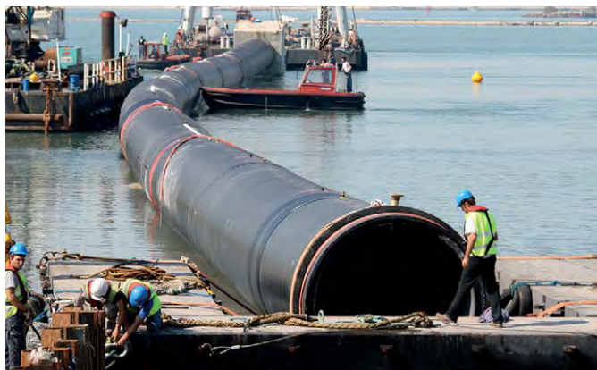
▲ Fos-Sur-Mer, Frankrike: kylvatten- och utloppsledningarna till ett kraftverk levererades som nyckelfärdigt projekt. Totalt installerades 1260 m Weholite-rör DNI/ID 2200–2400 mm SN 4, installationssträcka 205 m. Ledningens viktsättning gjordes med betongfyllda profiler.
