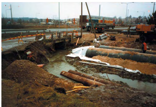
Bucklingsrisken för ett rör med en styvhets på minst SN=4 \text{ kN/m}^2 behöver endast kontrolleras när installationsdjupet överstiger 6 meter.
