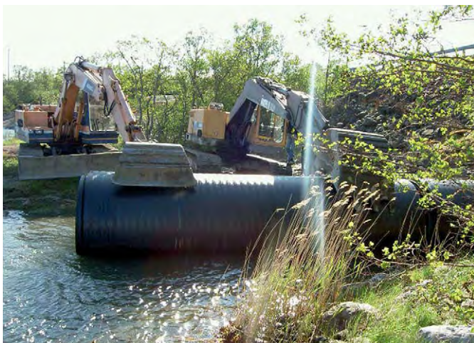
▲ Vasa, Finland: vid byte av rörrummor användes Weholite-rör DN/ID 700 mm.
