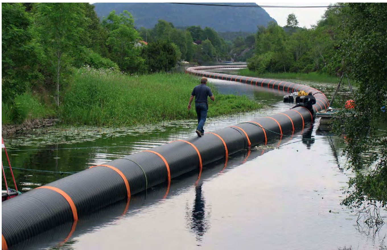
▲ Salar smolt, Bergen, Norge: för att kunna reglera vattentemperaturen till fiskodlingen Salar smolt byggdes en 1200 m lång Weholite DN/ID 1000 mm SN 4 intagsledning. Weholite-rör har samma flexibilitet som ett massivt PE-rör.
