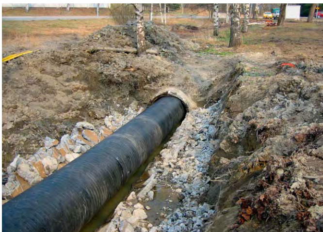
◀ Tavastehus, Finland: installationen under en motorväg utfördes genom att dra Weholite SN4 DN/ID 1000/1125 mm genom ett 1300 mm betongrör. Skarvmetod: svetsning, ledningens längd 750 m.
