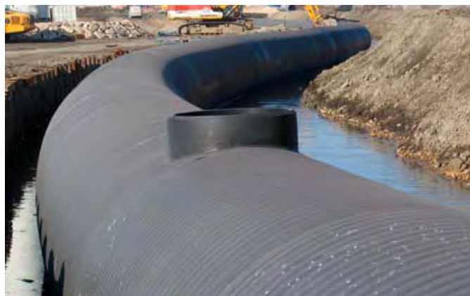
▲ Fos-sur-Mer, Frankrike: Weholite är ett av de sällsynta PE-rör i världen som tillverkas i storlekar över DN/ID 2000 mm.
