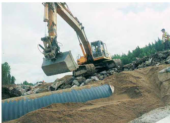
▲ Degerfors: järnvägstrummor Weholite DNI/ID 1800 mm, 2 x 24 m
