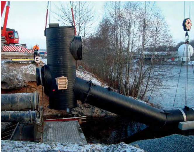
▲ Aitik 36, Gällivare: 660 m lång Weholite DN/ID 1600 mm, 2 bar processvatten ledning till Boliden Minerals anrikningsverk i Aitik.
