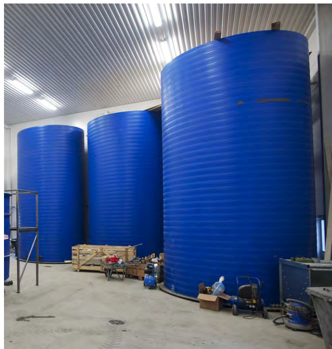
▲ Nedervetil, Finland: Weholite-tankar DNI/D 3000 mm är ett hygieniskt och totalekonomiskt alternativ med lång livslängd för förvaring av foder och djurföda. Gårdsbrukets fodertankar är de första i denna storleksklass i Finland som är tillverkade i polyeten.
