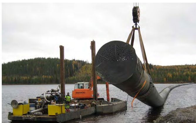
▲ Talvivaaragruvan, Sotkamo, Finland: intagsrör för färskvatten Weholite DN/ID 1600 mm. längd 250 m.
