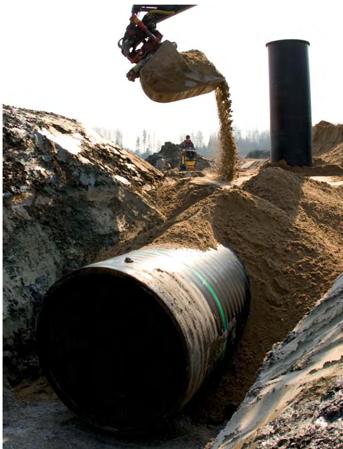
▲ Vanda, Finland: på ett 9 hektars markområde avsett för uppställning av bilar som tillhör ett logistikcenter ersattes de öppna dikena med Weholite-rör och då kan varje kvadratmeter av tomten utnyttjas. I projektet användes 258 m Weholite-rör DN/ID 1350/1200 mm och 198 m DN/ID 1575/1400 mm samt 11 Weholite-sadelbrunnar. Skarvarna var gängkopplingar och bandskarvar.
