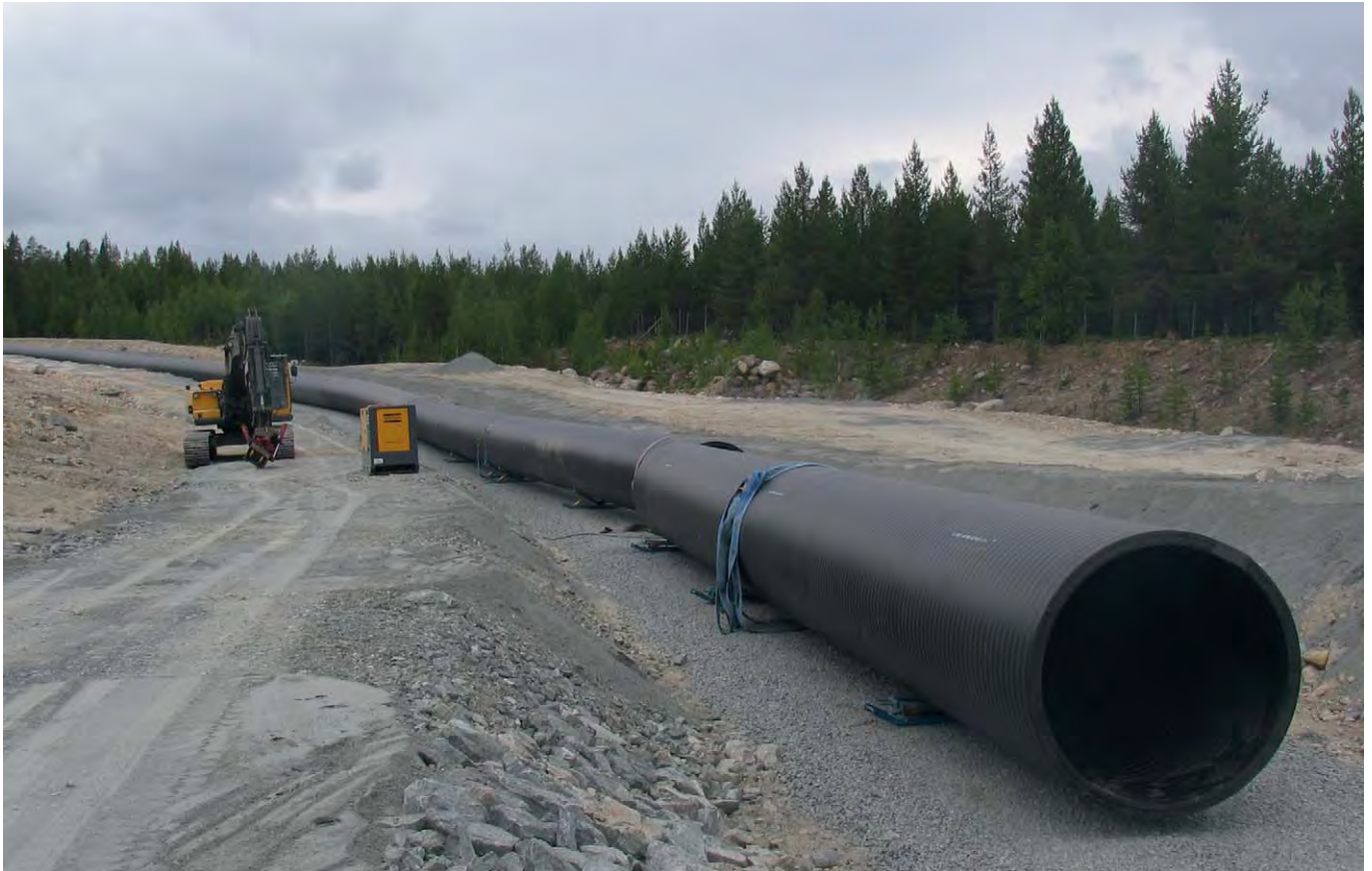
▲ Aitik 36, Gällivare: 660 m lång Weholite DN/ID 1600 mm, 2 bar processvatten ledning till Boliden Minerals anrikningsverk i Aitik.
