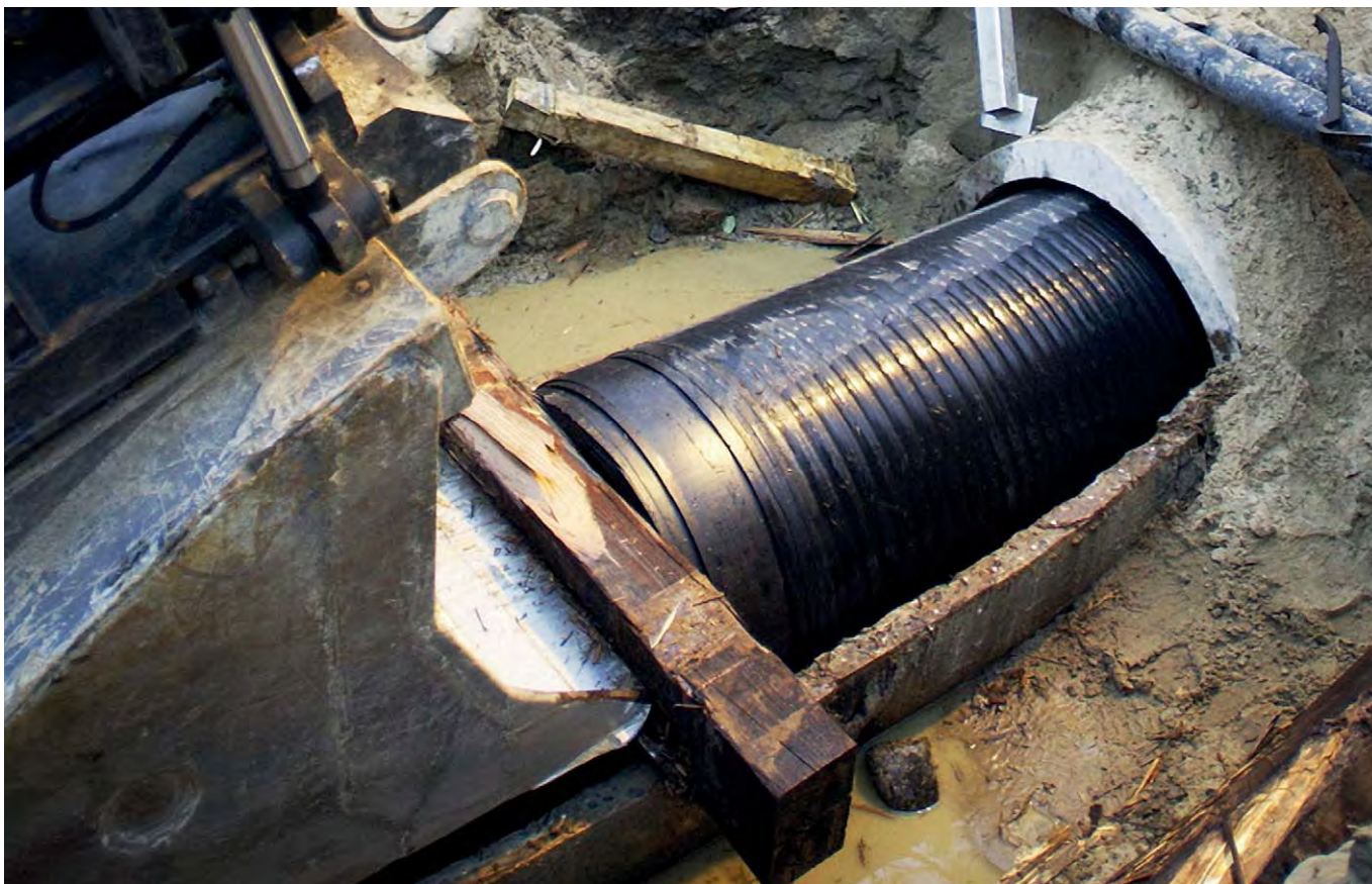
▲ Vasa, Finland: vid byte av rörrummor användes Weholite-rör DN/ID 700 mm.
