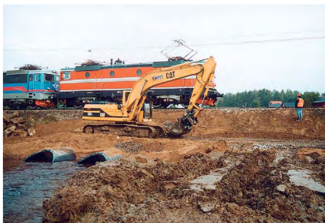
◀ Degerfors: järnvägstrummor Weholite DN/ID 1800 mm, 2 x 24 m
