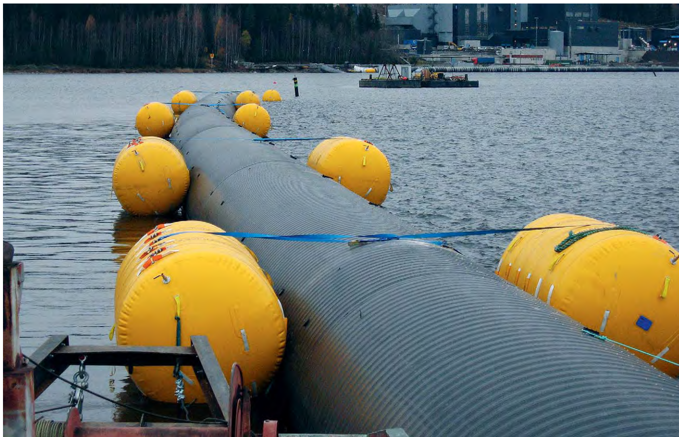
▲ Keljonlahti, Jyväskylä, Finland: överföringsrör för kylvatten till ett biokraftverk, Weholite DNI/ID 3 330/3000 mm. Rörlängd 20 m, installationssträcka 300 m. Den totala längden på intags- och utloppsledningarna för kylvatten är 1714 m.
