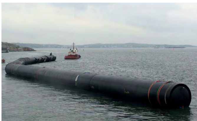
▲ Ryaverket, Göteborg: Weholite DNI/ID 2200 mm SN 4 utloppsledningen är 150 m lång och profilerna fylldes med en betongblandning för att sänka ledningen.
