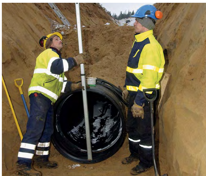
◀ Koskenkylä-Kouvola, Finland: Riksväg 6. En gammal och farlig väg blev modern och bred. Alla trummor för vägbygget gjordes av Weholite DNI/ID 360–2000 mm.
