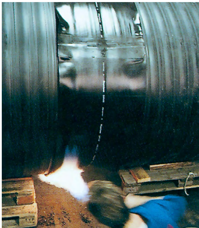
▲ Tätning av rör med krympförband
