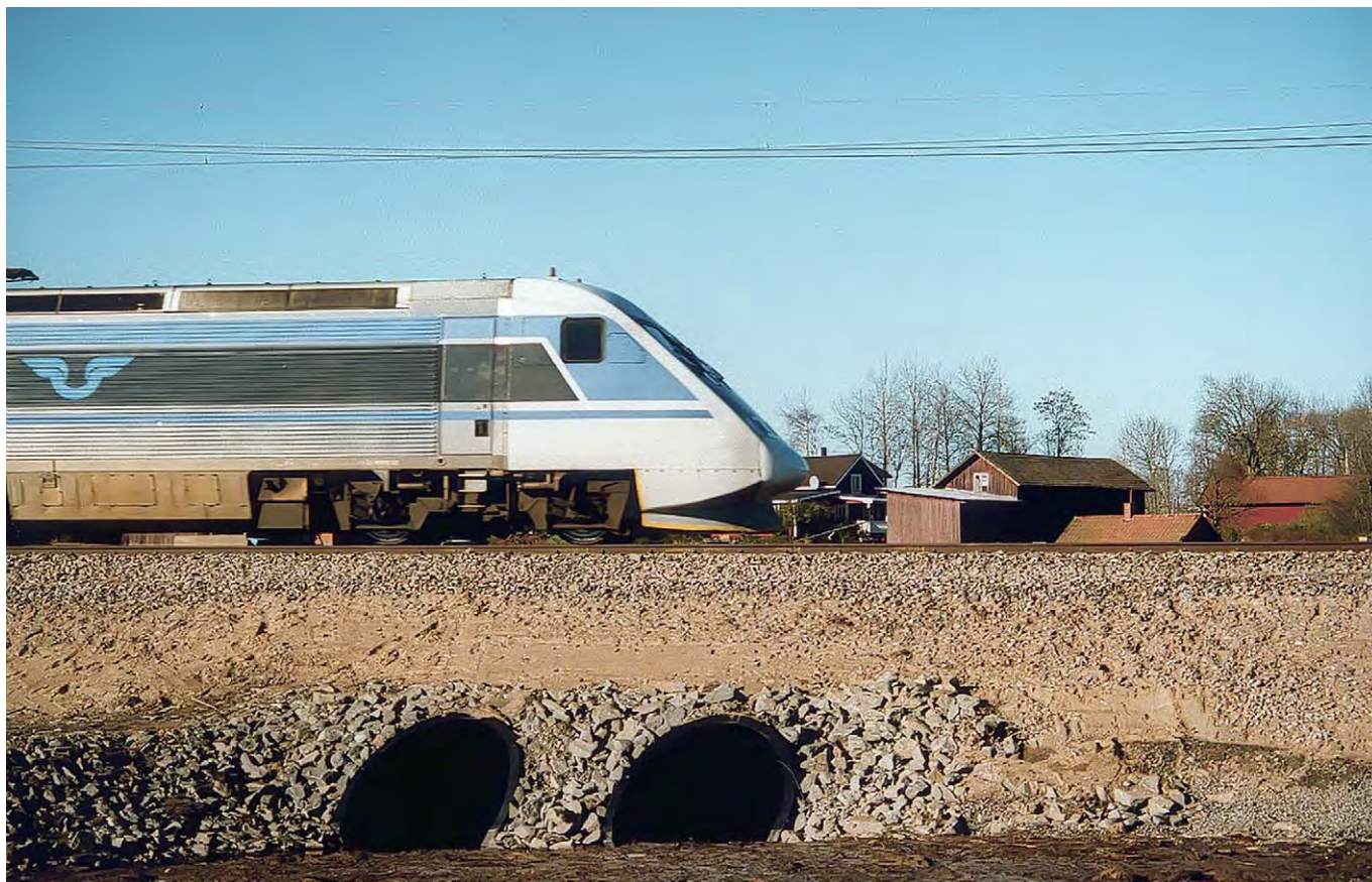
▲ Degerfors: järnvägstrummor Weholite DNI/ID 1800 mm, 2 x 24 m
