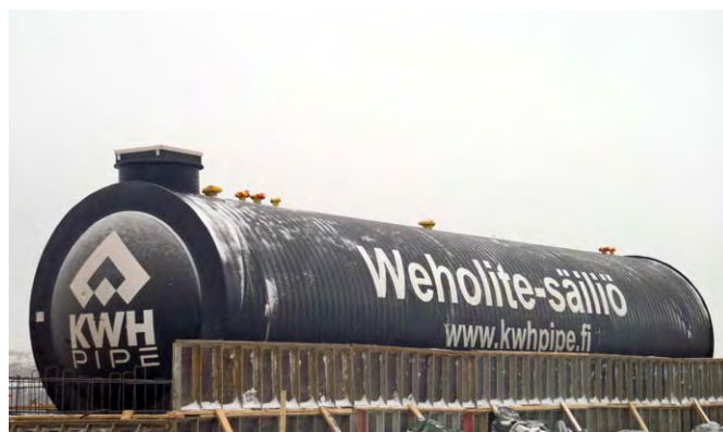
▲ Gruvan i Talvivaara, Finland: Weholite-tank för lagring av lut. Volym 50 m 3 , DN/ID 2400 mm, längd 12 m. Installerad ovan mark.
