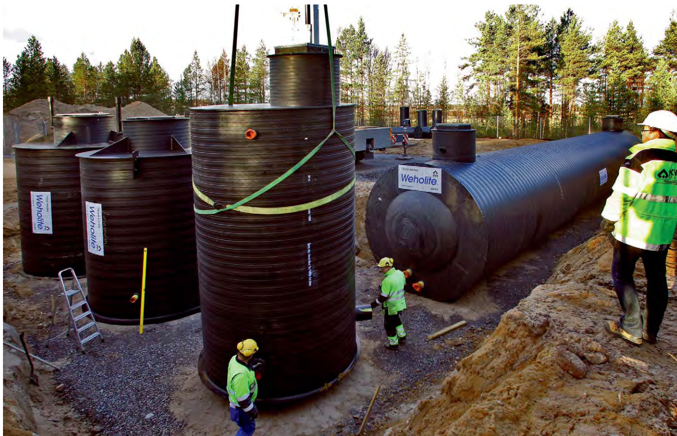
▲ Lumijoki, Finland: en alkaliseringsanläggning placerad i närheten av en vattentäkt säkerställer rätt pH-värde hos vattnet vilket förhindrar att komponenterna i vattenledningssystemet korroderar. Det fabrikstillverkade systemet installeras lätt och snabbt.
