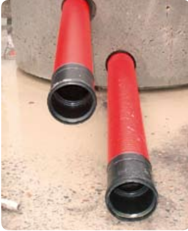
Kuva 7.2.11 Triplan läpivienti betoni-kaivoon
