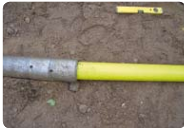
Kuva 7.2.21 Tripla-putken kiinnittäminen porauslaitteeseen
