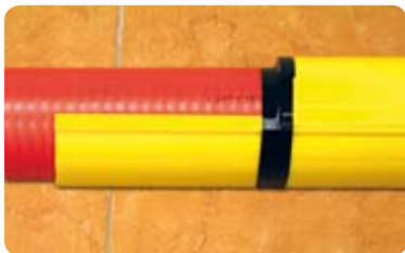
Kuvat 7.2.14 ja 15 Vaurioituneen Tripla-putken korjaaminen halkaistulla putkella.
