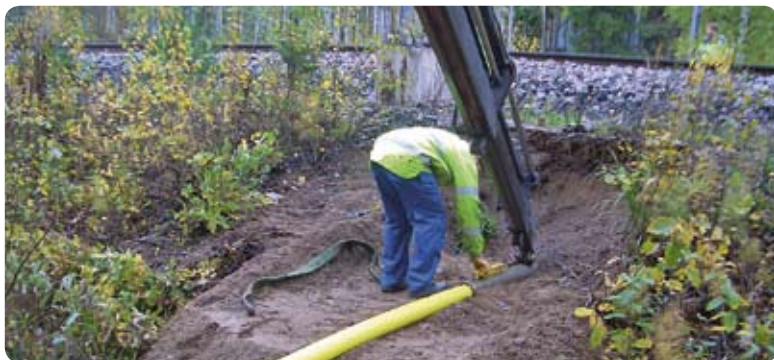
Kuva 7.2.22 Tripla-putken rautatien alitus myyrän avulla. Alituksen pituus 15 m
