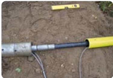
Kuva 7.2.20 Tripla-putken kiinnitys myyrään
