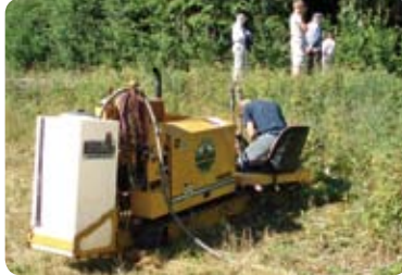
Kuva 7.2.25 Vaakaporaamalla tehty tienalitus 12 m
