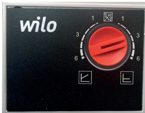
Bild: Justering av cirkulationspump
