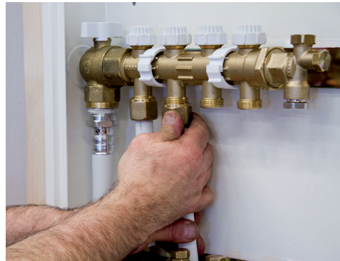
14. Skruva fast kopplingen i fördelaren.
