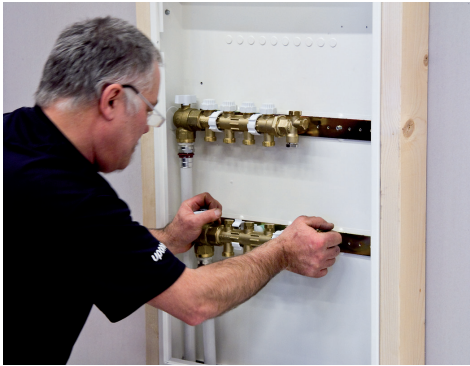
11. Montering av matningarna underlättas om fördelarna monteras lite förskjutna.
