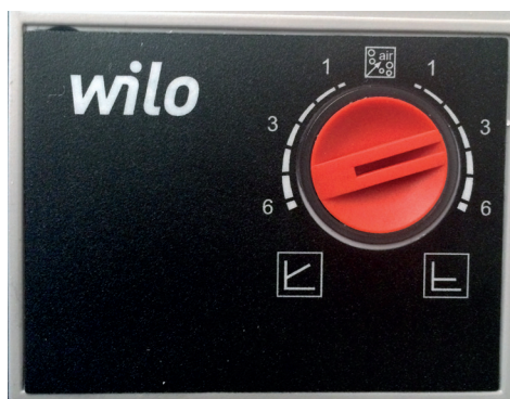
Bild: Justering av cirkulationspump
