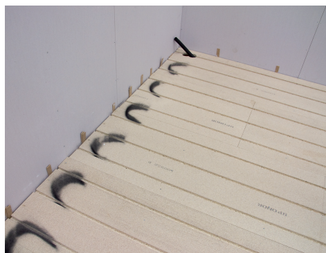
14. Markera var röret ska vända på spånski- vorna för att underlätta fräsningen.
