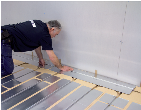
13. Montera plåtar även i matningsspåret.
