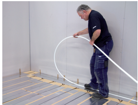
14. Montera golvvärmeröret.
