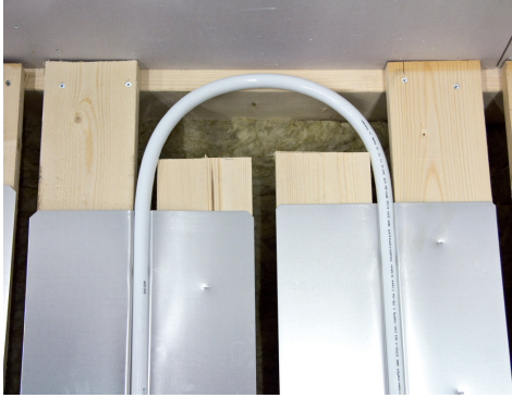
11. Exempel på korrekt vändning av röret.
