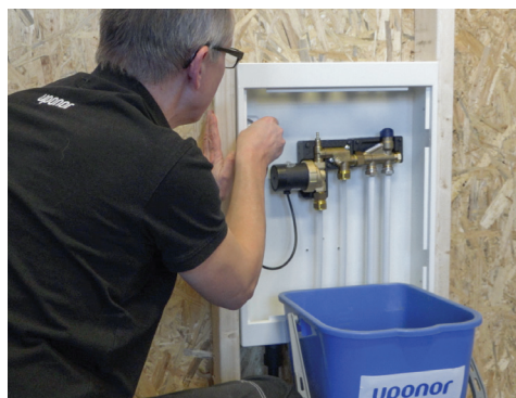
13. Anslut till nätspänning och starta värmesystemets primärpump.
