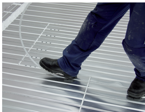
11. Rördragning i rakt spår.
