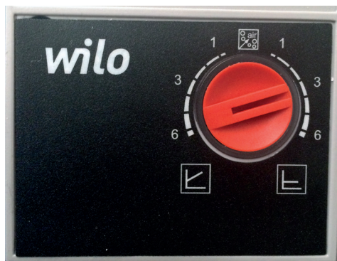
Bild: Justering av cirkulationspump
