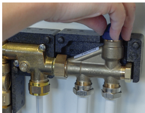
12. Öppna ventilen på radiatorkopplet.
