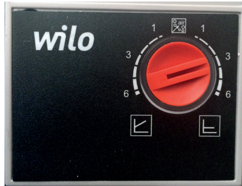
Bild: Justering av cirkulationspump
