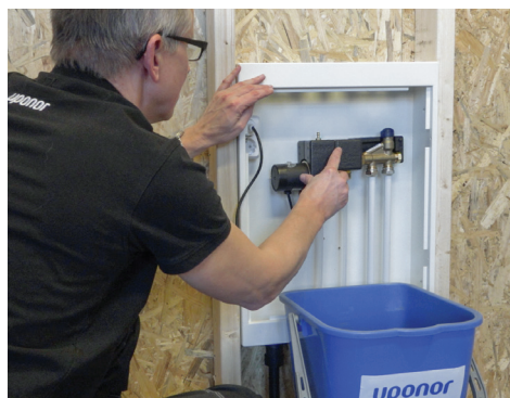
14. Montera isolersatsen för bästa energieffektivitet.
