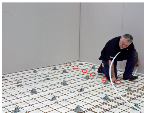
4. Fäst röret så att röret bara najas på varsin sida om vändningen.
