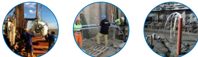
Instalación de sondas geotérmicas Uponor Geo Vertis (PEX-a)
