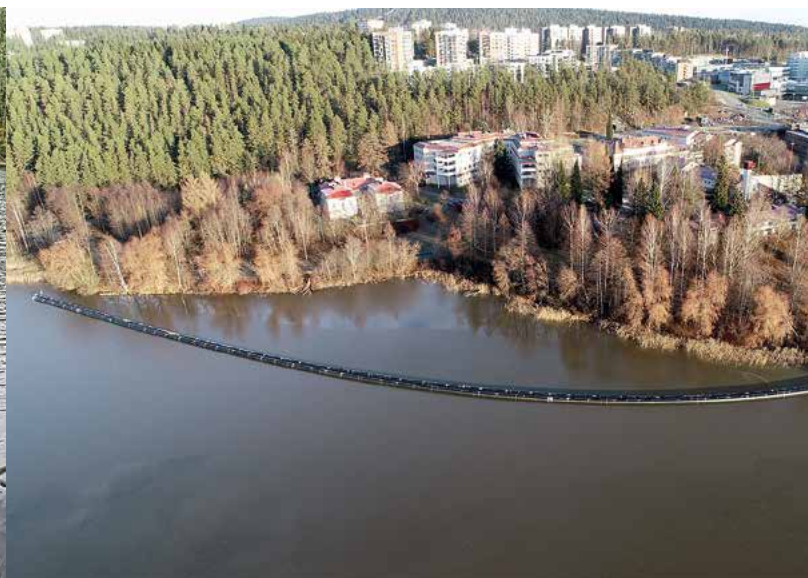
Yli 300 metrin pituiset putkiletkat odottavat upotusta Kallavedessä.
