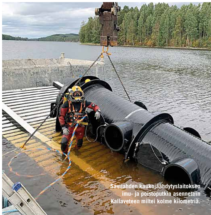
Yli 300 metrin pituiset putkiletkat odottavat upotusta Kallavedessä.
