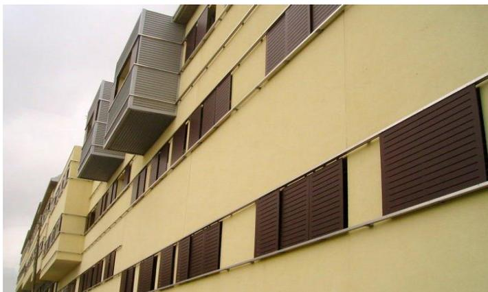
Imagen 20. Ejemplo genérico de lamas correderas en la fachada de un edificio (Fuente: Trespa)
