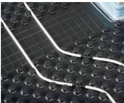
Striscia utilizzata in corrispondenza di un passaggio porta tra ambienti
