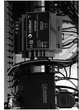
6. Flytta reläet till höger så att modemet får plats mellan reläet och skåpsväggen.
