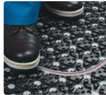
Praktische Ein-Mann-Montage der Uponor PE-Xa Rohre
