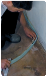
Uponor Minitec Randdämmstreifen montieren
