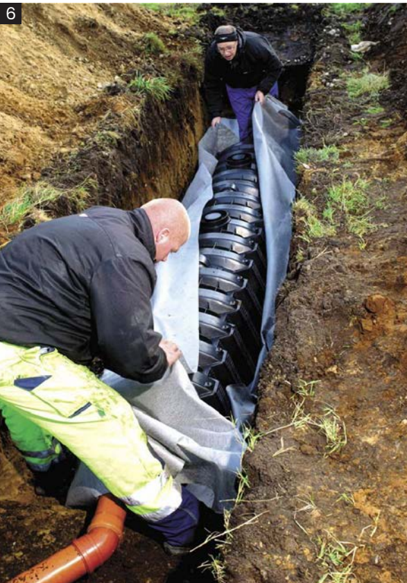
4. Hulevesitunnelijonot päällystetään suodatinkankaalla (käyttöluokka 2) saumat vähintään 30 cm päällekkäin
