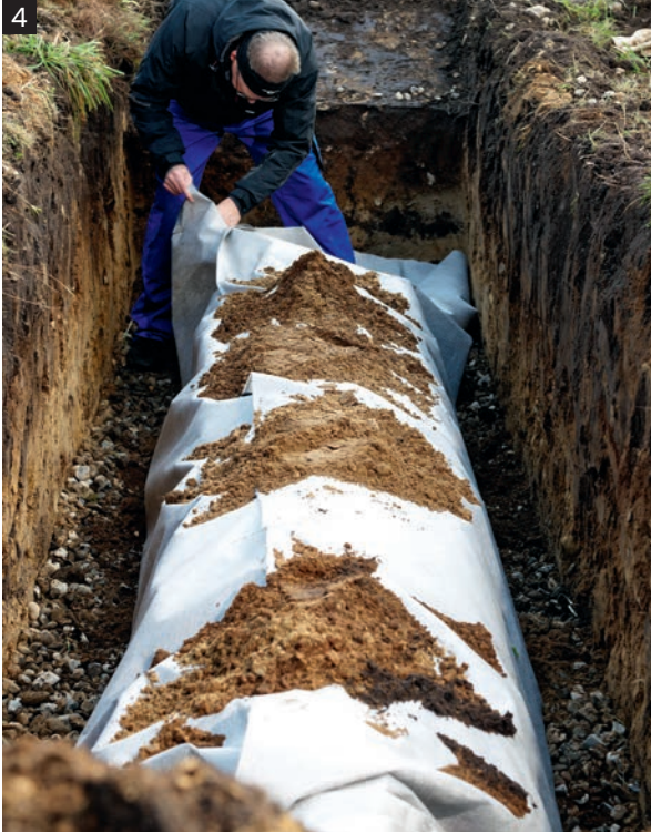
4. Hulevesitunnelijonot päällystetään suodatinkankaalla (käyttöluokka 2) saumat vähintään 30 cm päällekkäin
