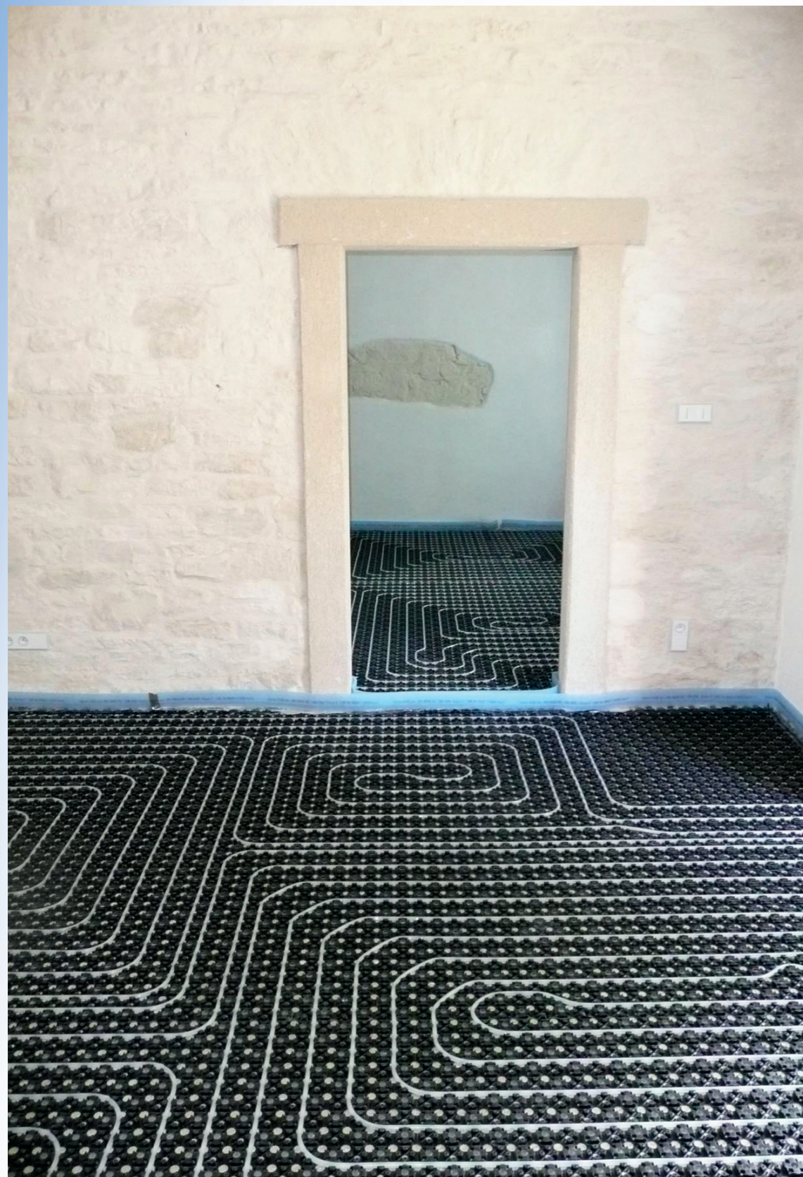
Otopný had PV pro obývací pokoj s místem pro krbová kamna
