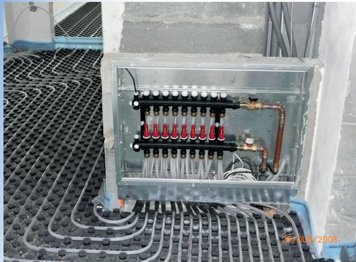
Napojení podlahového vytápění na rozdělovač
