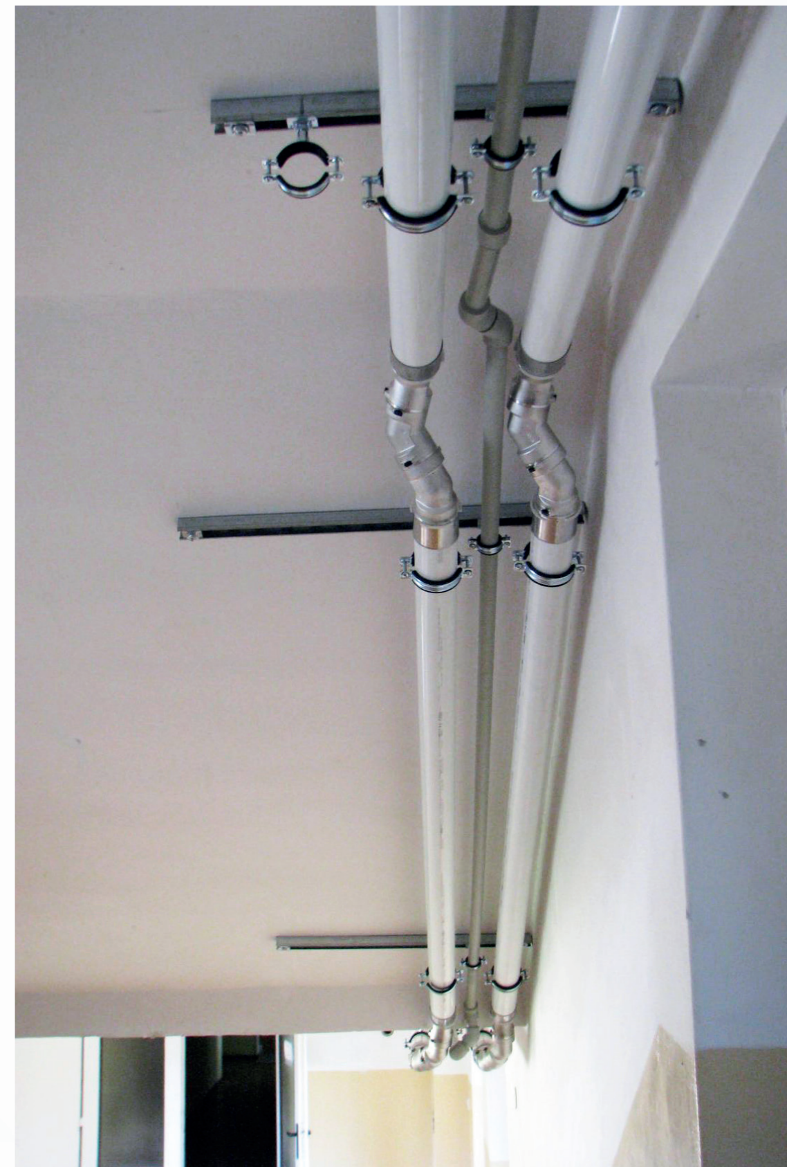
Pohled na páteřní rozvod vedený pod schody připravený k zalisování
