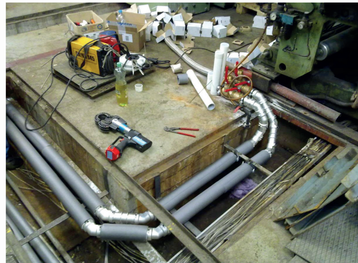
Zaizolování spojeného potrubí
