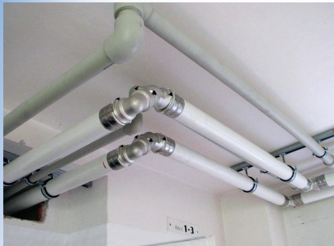
Detailní pohled na zalisované spoje
