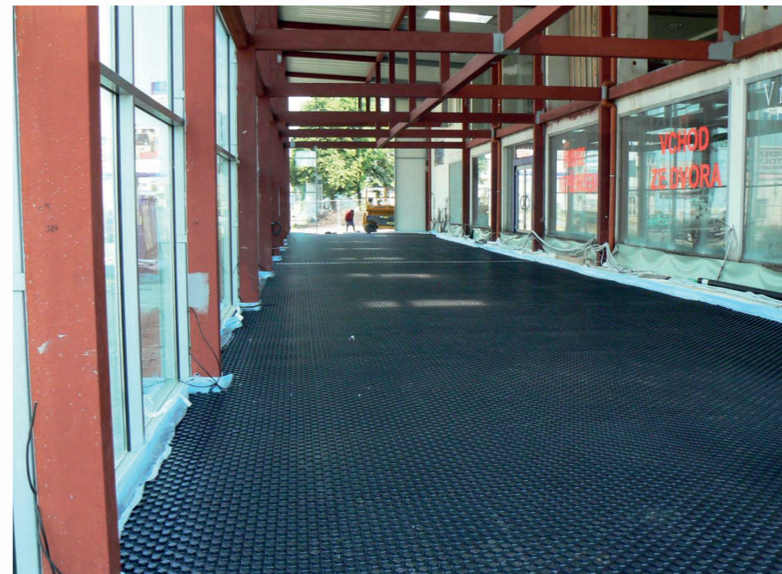
Plocha s položenou systémovou deskou ND 11 před instalací smyček podlahového vytápění
