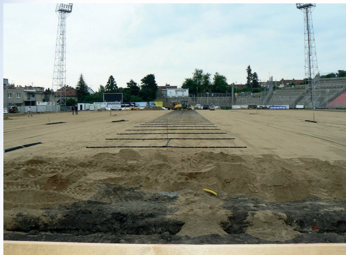
První připravené svěrné lišty pro ukotvení potrubí
