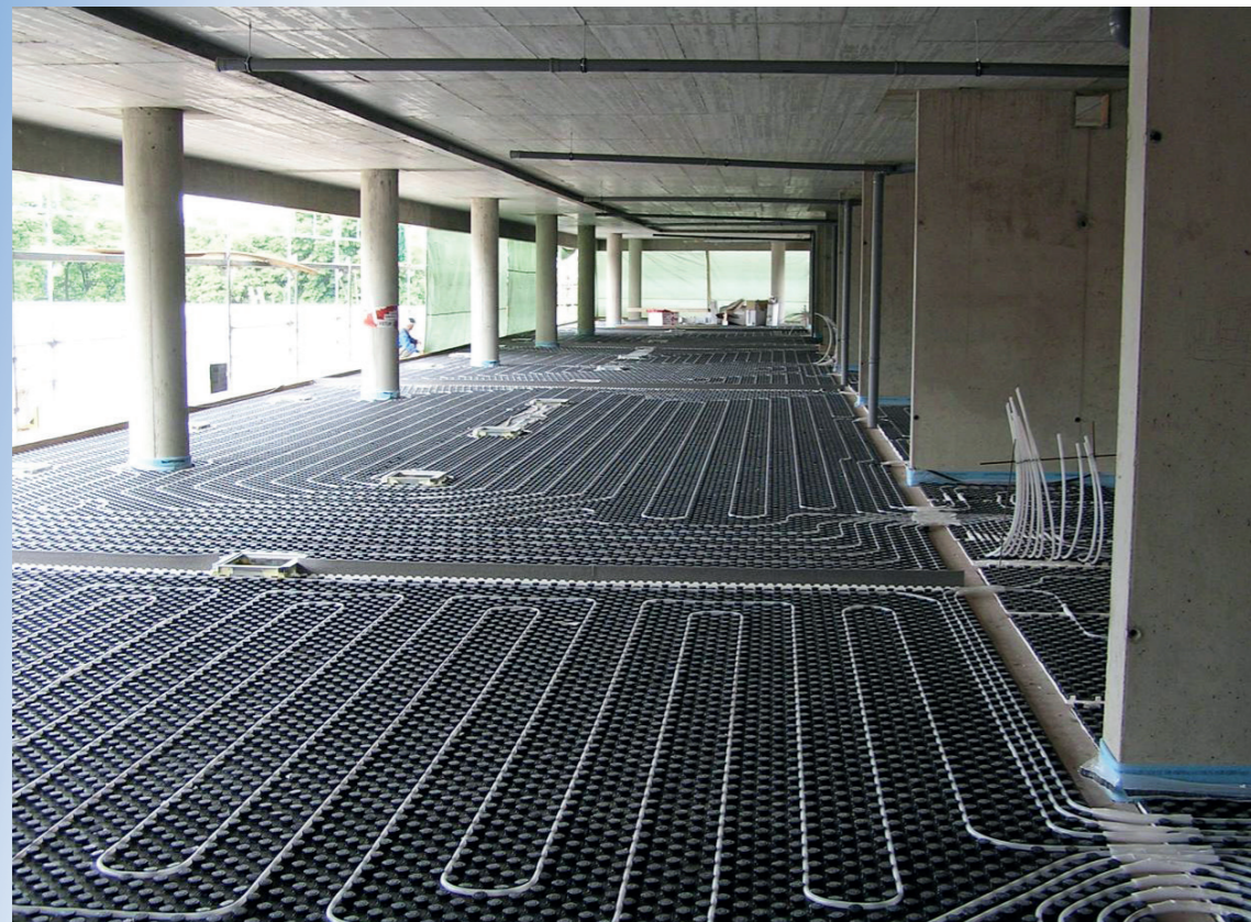
Vývody z podlahového vytápění jsou připraveny pro připojení k rozdělovači ihned po jeho instalaci.
