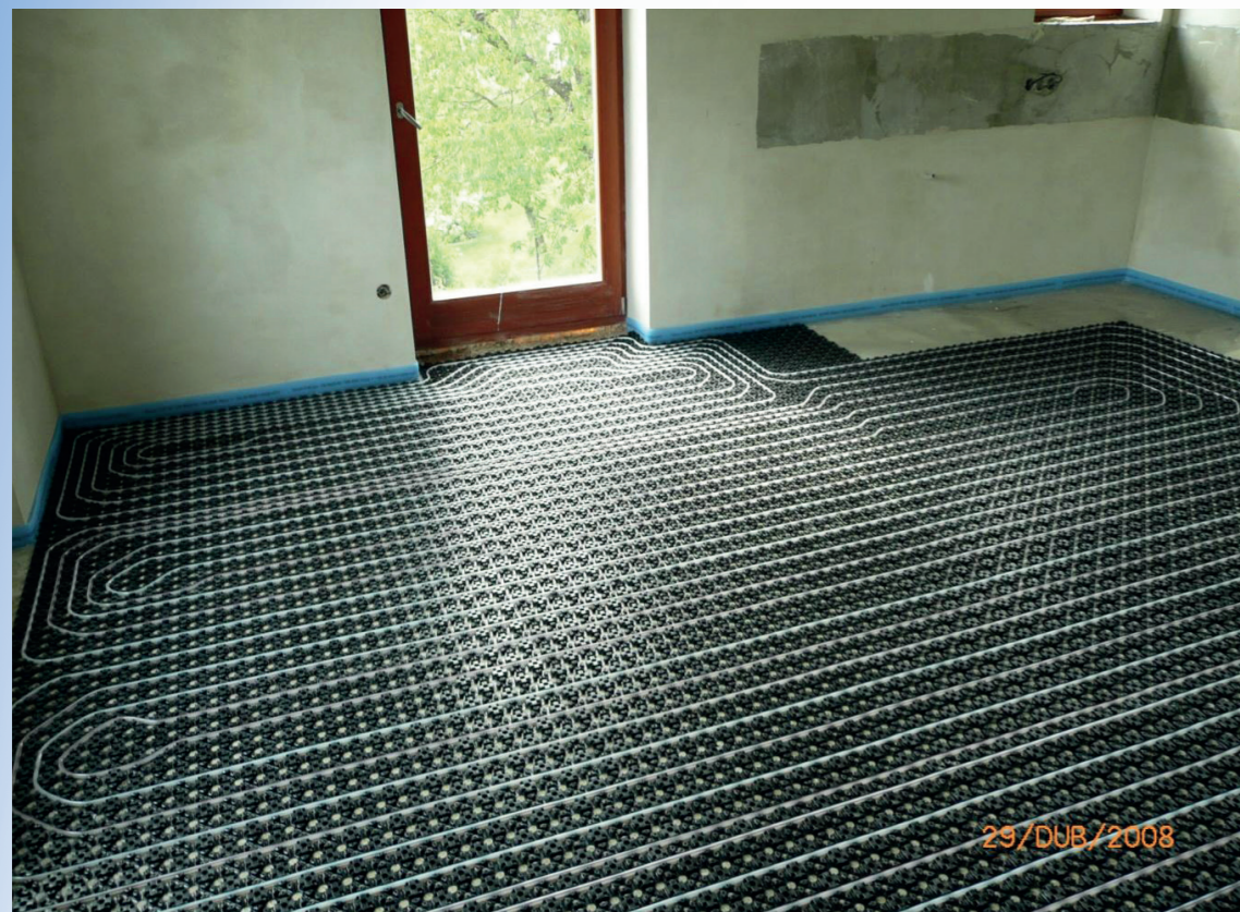
Položená podlahová konstrukce s vynechanou plochou pro kuchyňskou linku
