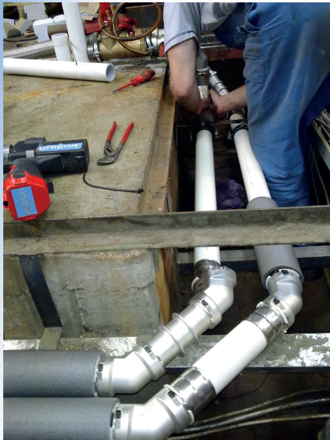
Spojování potrubí pod úhlem 45°
