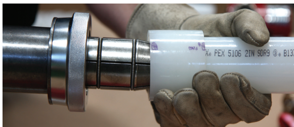
Figure 22 : Glisser la tête sur le tuyau
