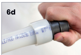
Figure 6 : Raccord ProPEX inséré dans un tuyau PEX de 1"
