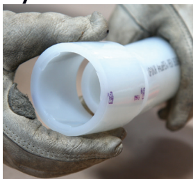
Figure 21 : Ajouter la bague
