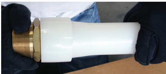
Figure 29 : Raccord en laiton ProPEX raccordé au tuyau
