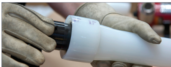
Figure 26 : Insérer le raccord
