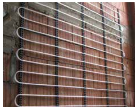
Sistem umed pe șină de montaj
