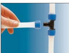
**Passo 6. Efectuar a união:** manter o tubo no seu sitio, contra o batente do acessório, durante pelo menos 3 segundos. Findo este tempo, o tubo terá já começado a sua contracção sobre o acessório. Passar à próxima união. A montagem pode ser feita sob uma temperatura ambiente mínima de -15°C. Para o efeito de realizar uniões Q&E podem ser utilizados o expansor manual, um expansor a bateria ou ainda, o expansor hidráulico.
