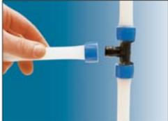
**Paso 6. Efectuar la unión:** mantener el tubo en su sitio, contra el tope del accesorio, durante 3 segundos. Al cabo de este tiempo la tubería se habrá contraído sobre el accesorio, y se puede realizar otra unión. El montaje puede hacerse hasta una temperatura ambiente mínima de -15°C. Se puede utilizar el expandidor manual, de batería o el hidráulico.
