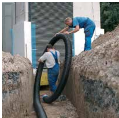
Jednoduchá manipulácia s Ecoflex Thermo a Thermo PRO vďaka neobyčajnej flexibilitě vo svojej triede.
