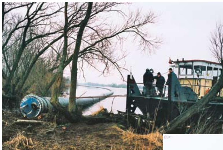
Fot. 7. Wyspa Pucka. Splawianie rurociągu po Kanale Parnickim
