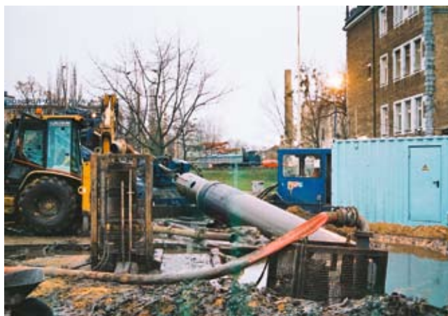
Fot. 10. Ul. Celna. Koniec wciągania rurociągu pod rz. Odrą
