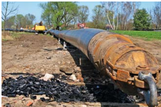
Fot. 9. Wyspa Pucka. Rurociąg przygotowany do wciągnięcia do przewiertu pod rz. Odrą
