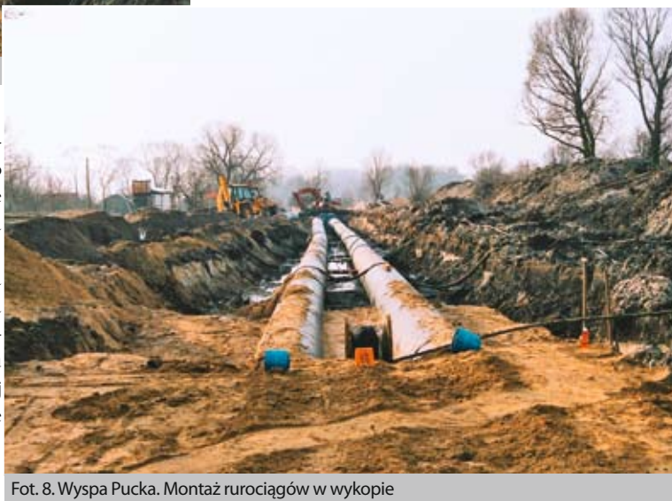
Fot. 8. Wyspa Pucka. Montaż rurociągów w wykopie
