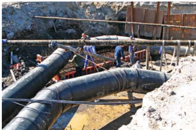
Fot. 11. Ul. Celna. Połączenie odcinka wykonanego w wykopie z odcinkiem wykonywanym przewiertem sterowanym
