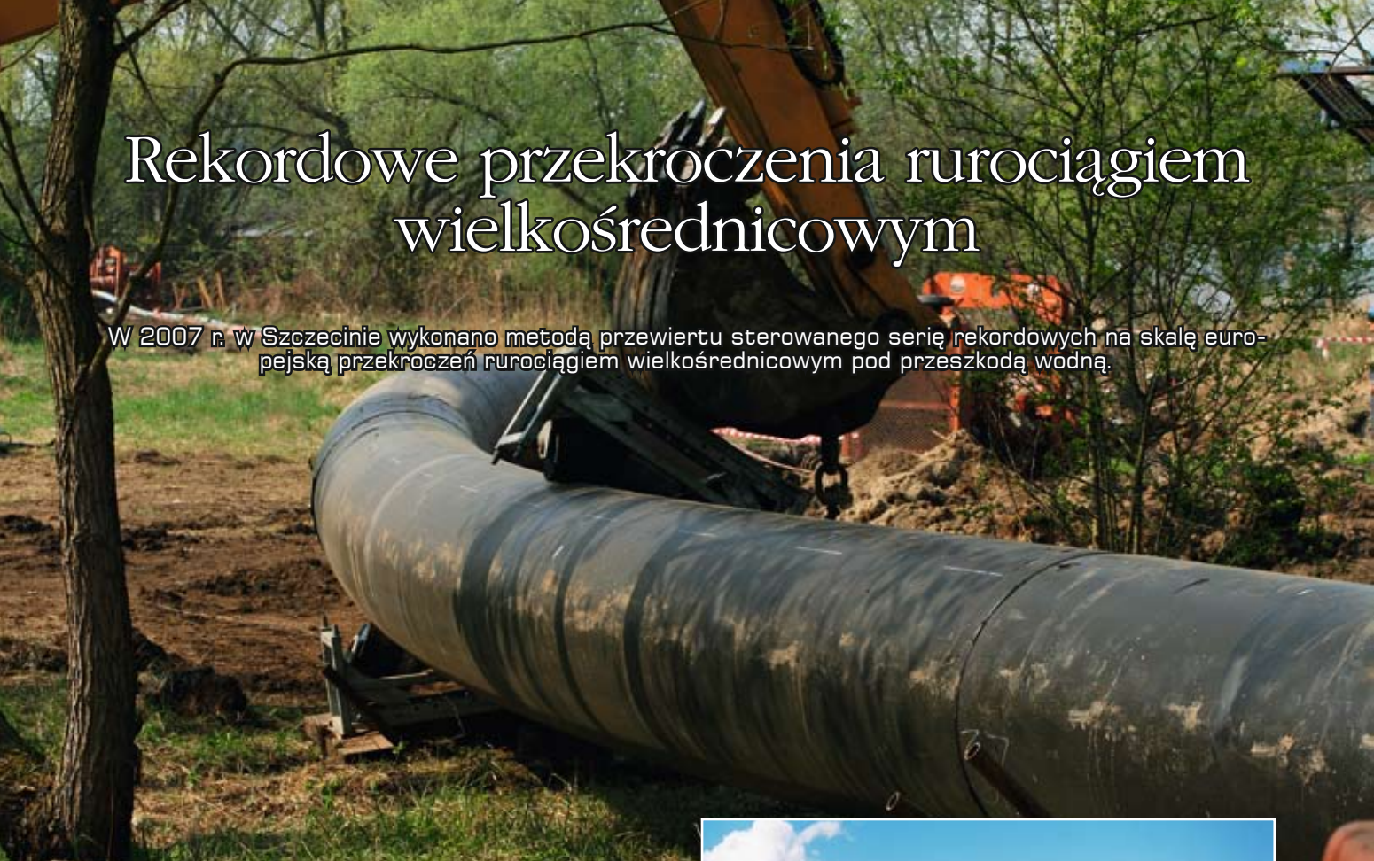
Fot. 1. Wyspa Pucka. Wciąganie rurociągu do przewiertu pod rz. Odrą
