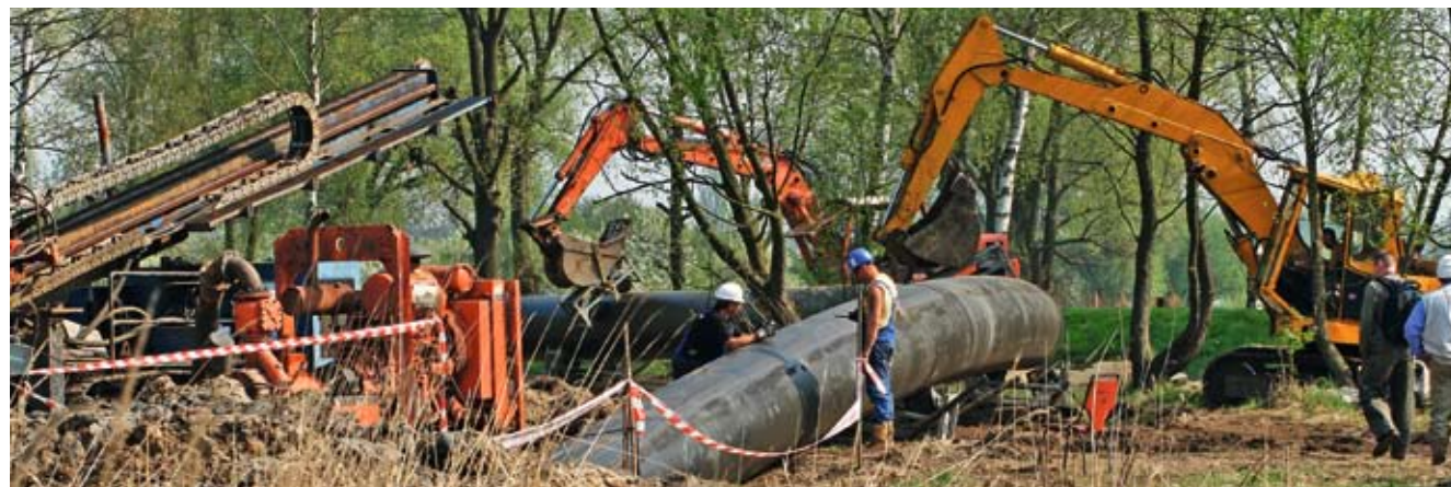
Fot. 11. Ul. Celna. Połączenie odcinka wykonanego w wykopie z odcinkiem wykonywanym przewiertem sterowanym
