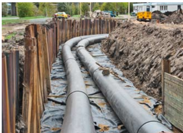
Fot. 5. Ul. Energetyków. Montaż rurociągów w wykopie
