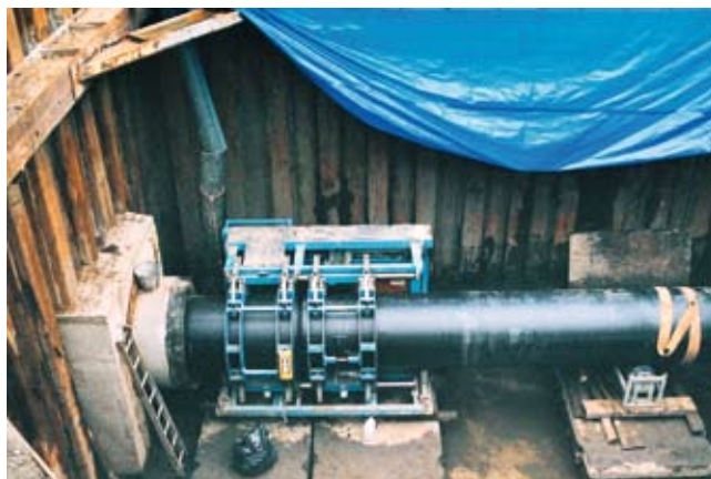
Fot. 4. Ul. Jana z Kolna. Zgrzewanie rurociągu w komorze precyzyjnej mikrotunelingu
