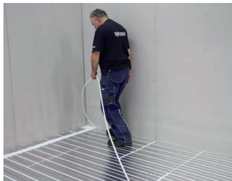
10. Montera genom att trampa ner röret i spåret (bilden visar rördragning i framledningen)
