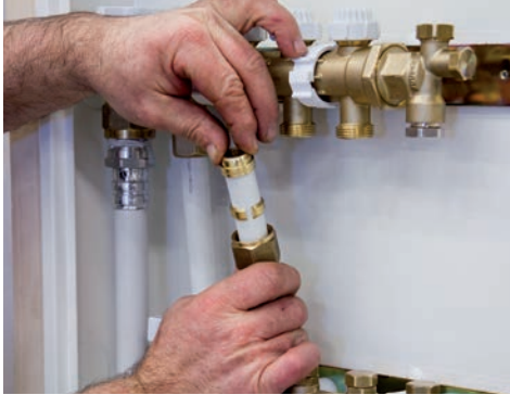
13. Kapa PEX-röret i rätt längd och montera kopplingsset.
