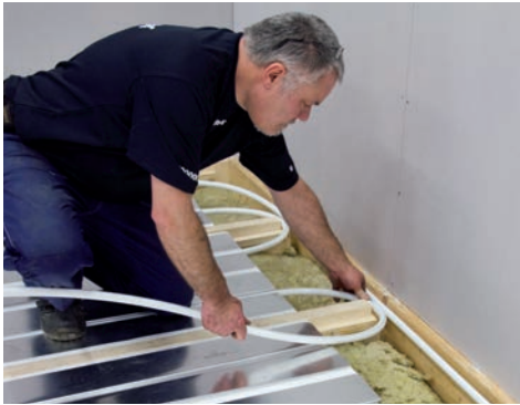
11. Vändöglorna kan hållas på plats med ett skruvband.
