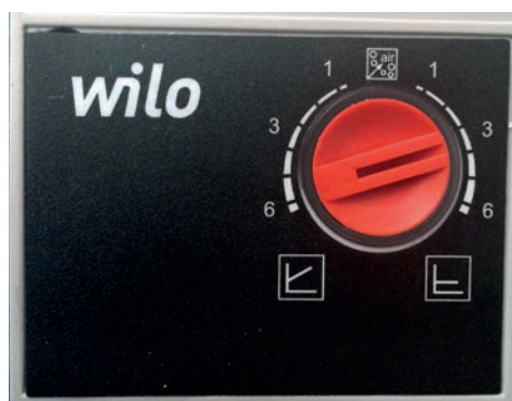
Bild: Justering av cirkulationspump
