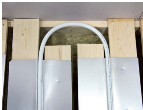
11. Exempel på korrekt vändning av röret.
