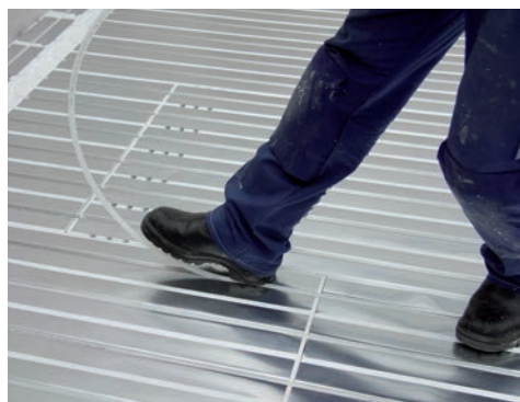
11. Rördragning i rakt spår.
