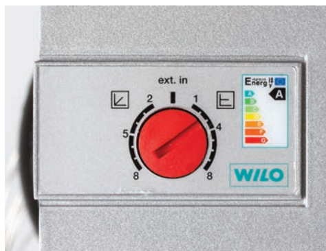
Bild: Justering av cirkulationspump
