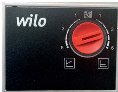
Bild: Justering av cirkulationspump
