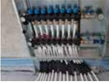
Los colectores son los componentes de la instalación que conectan las tuberías de distribución provenientes de la fuente de energía con los diferentes circuitos integrados en el suelo radiante. Equilibran hidráulicamente la instalación y controlan termostáticamente cada estancia.
