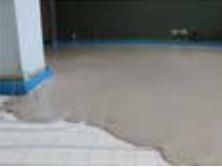
Una vez trazados todos los circuitos en la superficie a climatizar, se le vierte el mortero que confiere al sistema la inercia térmica para poder gestionar la emisión del calor necesario según cada estancia.
