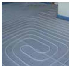
Componente por el que circula agua a distintas temperaturas dependiendo del modo de funcionamiento (calefacción o refrigeración). Suelen utilizarse tuberías de diámetro 16 mm (obra nueva) y de 9,9 mm (reforma, bajo perfil) fabricadas con polietileno reticulado PEX-a según norma UNE-EN- ISO 15875 con capa de EVOH (etilvinil-alcohol) para impedir la difusión de oxígeno según DIN 4726, y evitar la corrosión y oxidación de la instalación a lo largo del tiempo.
