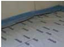
Consiste en una espuma de polietileno, cuya función principal es absorber las dilataciones producidas por el mortero de cemento colocado sobre los tubos. Estas dilataciones son inevitables durante el funcionamiento de la instalación ya sea en modo calefacción y/o refrigeración.
