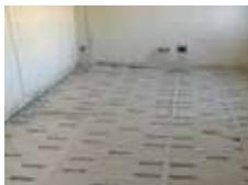
Este elemento, fabricado en polietileno, se coloca sobre el forjado. Se convierte en una barrera entre el forjado base y la superficie emisora de suelo radiante, evitando las posibles humedades que avanzan por capilaridad. Imprescindible en aquellas plantas bajas o sótanos en contacto con el terreno o cuartos húmedos.
