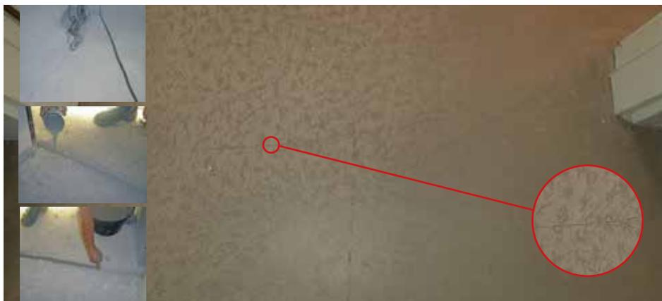
Ejemplo de fisuración. En este caso, no se puso junta de dilatación bajo el marco de la puerta.
