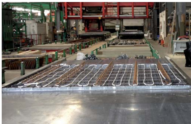
Prefabricerade plattbärlag i tillverkningsanläggningen.
