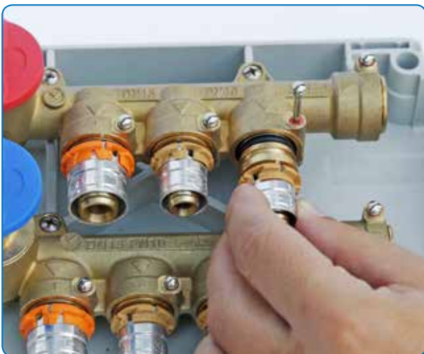
3. Posizionare il raccordo
