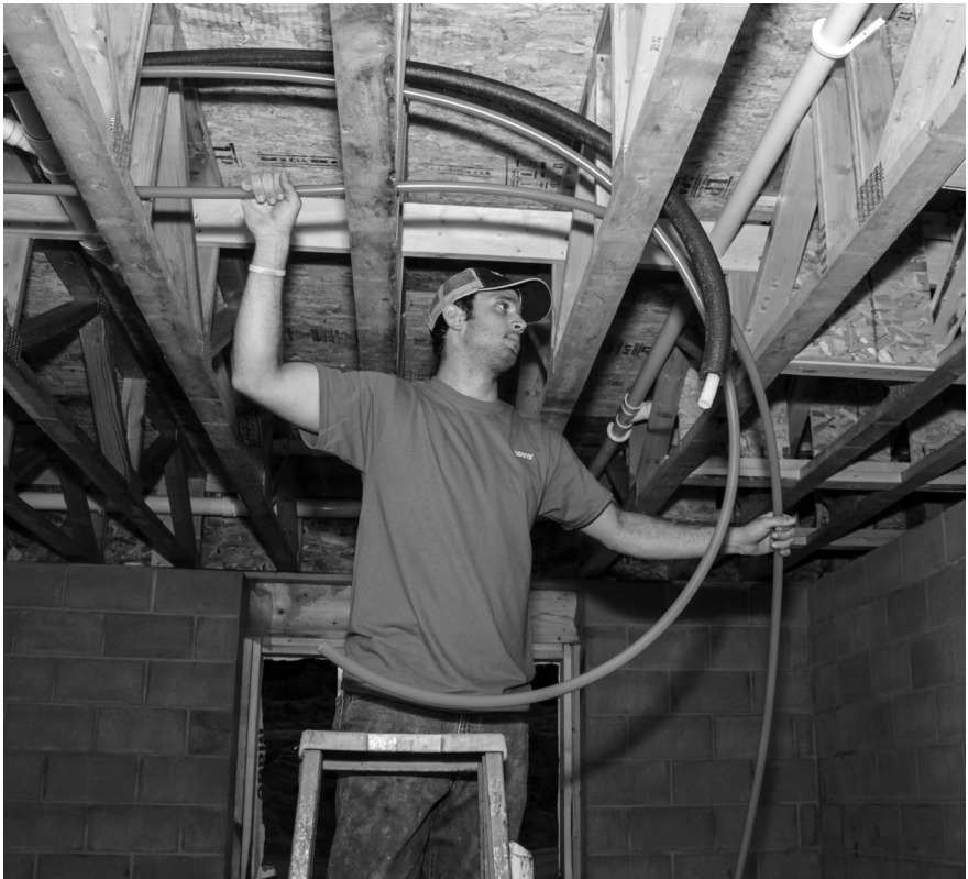
Figura 5-1: Colocación de tramos centrales de AquaPEX de Uponor al pasar por entramados con armazón abierto
