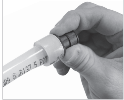
Figura 3-12: Introducir el accesorio
