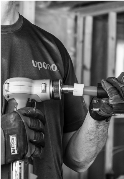
Figura 3-5: Realizar una conexión ProPEX
