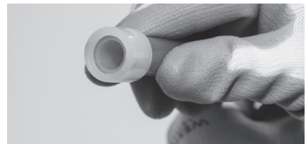
Figura 3-8: Asegure que la tubería llegue al borde de tope del anillo
