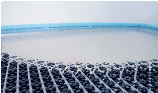
...ogrzewanie podłogowe z minimalną wysokością wylewki
