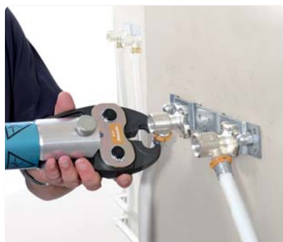
Prefabrykowane elementy instalacji w różnorodnym wykonaniu umożliwiają szybki postęp w montażu
