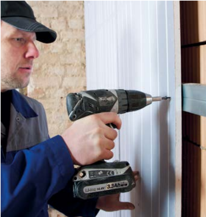
Minimalna debljina od 50 mm za potpunu ugradnju
