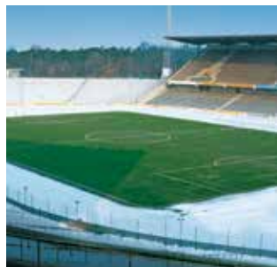
Uponor vyhřívá trávníky na mnoha stadionech, které jsou díky tomu k dispozici po celý rok.
