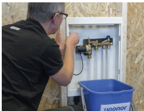
13. Anslut till nätspänning och starta värmesystemets primärpump.
