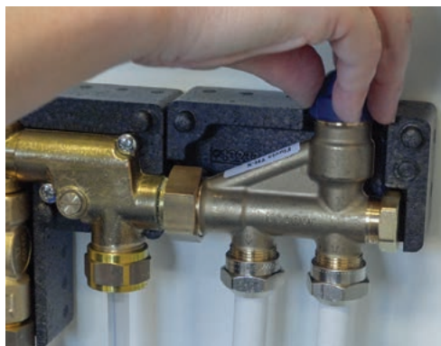
12. Öppna ventilen på radiatorkopplet.
