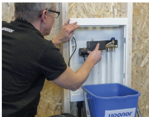
14. Montera isolersatsen för bästa energieffektivitet.
