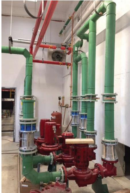
**Figura 1-5: Tubería PP-RCT en el cuarto de máquinas**
