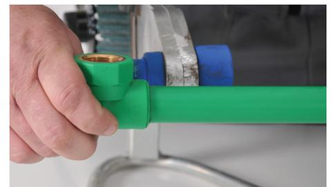
Figura 2-5: Permitir que el tubo fusionado se enfríe ininterrumpido
