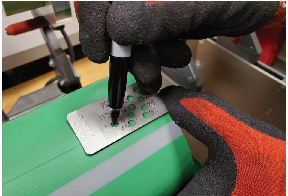
Figura 2-2: Marque la profundidad de la soldadura
