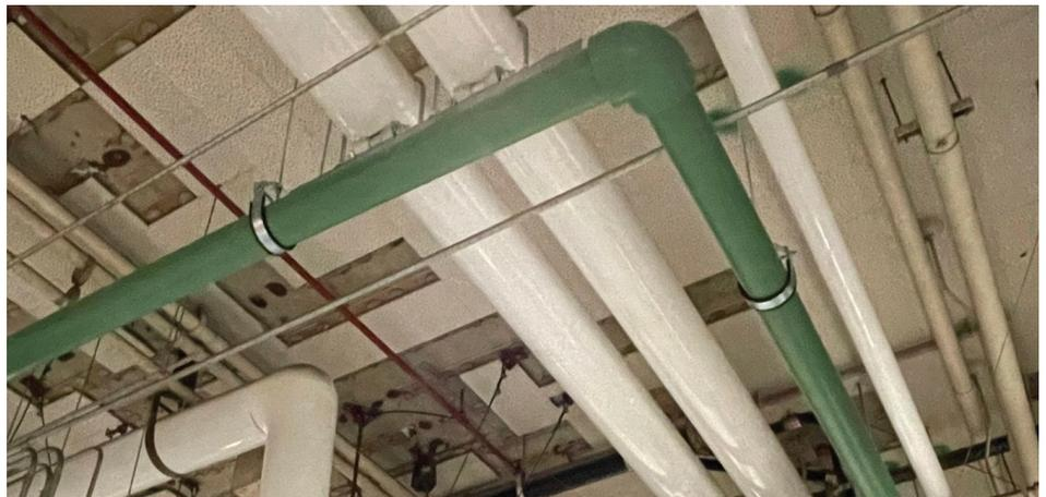
**Figura 5-2: Apoyar a tubería PP-RCT de Uponor**
