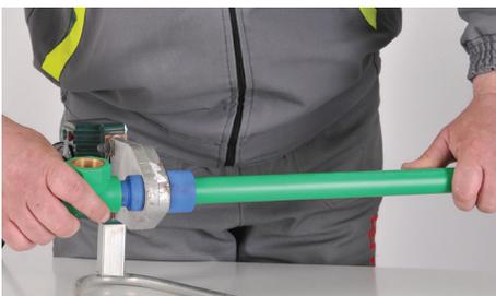
Figura 2-3: Calentamiento de la tubería y el accesorio
