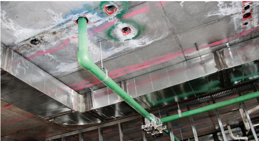
Figura 3-1: Penetración del techo
