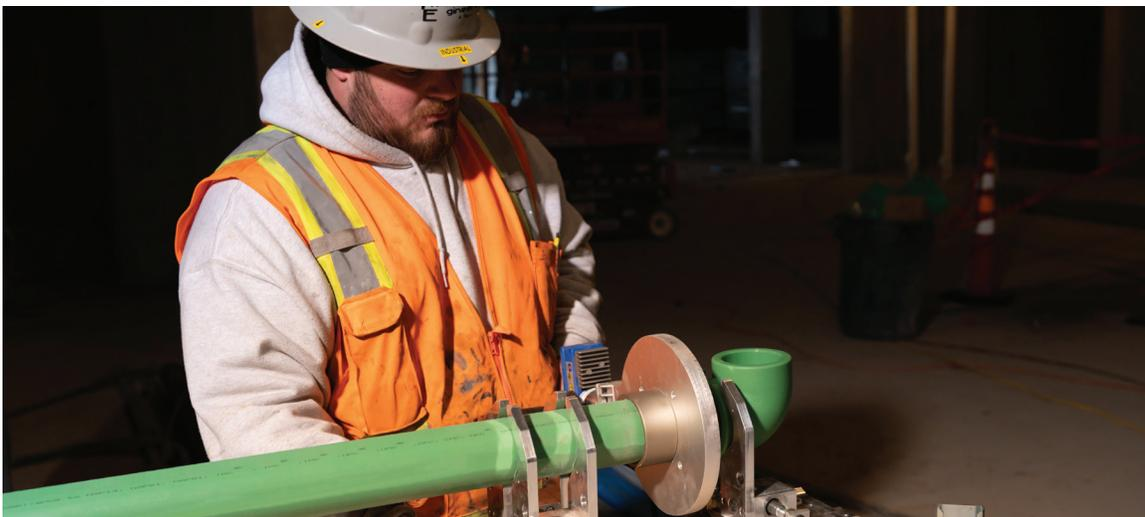
**Figura 2-1: Conexión de fusión por calor**
