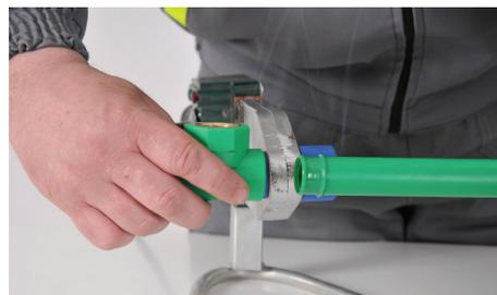
Figura 2-4: Conexión de la tubería y el accesorio
