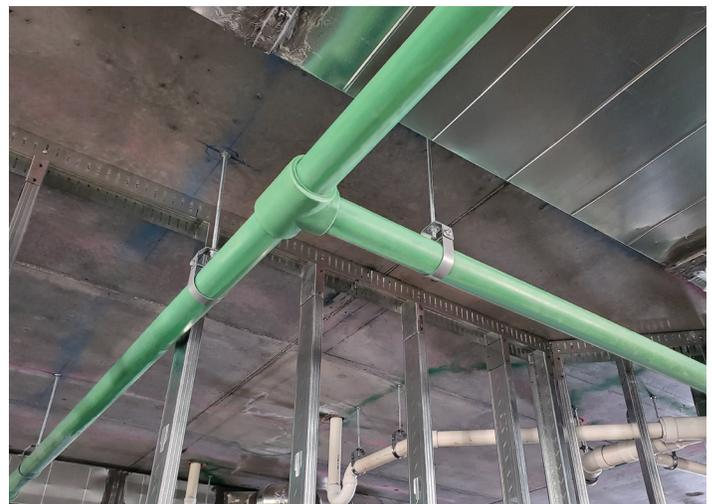
**Figura 1-4: Tubería PP-RCT suspendida**
