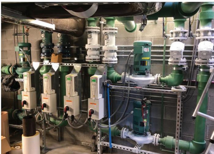
**Figura 1-3: Tubería PP-RCT en el cuarto de máquinas**
