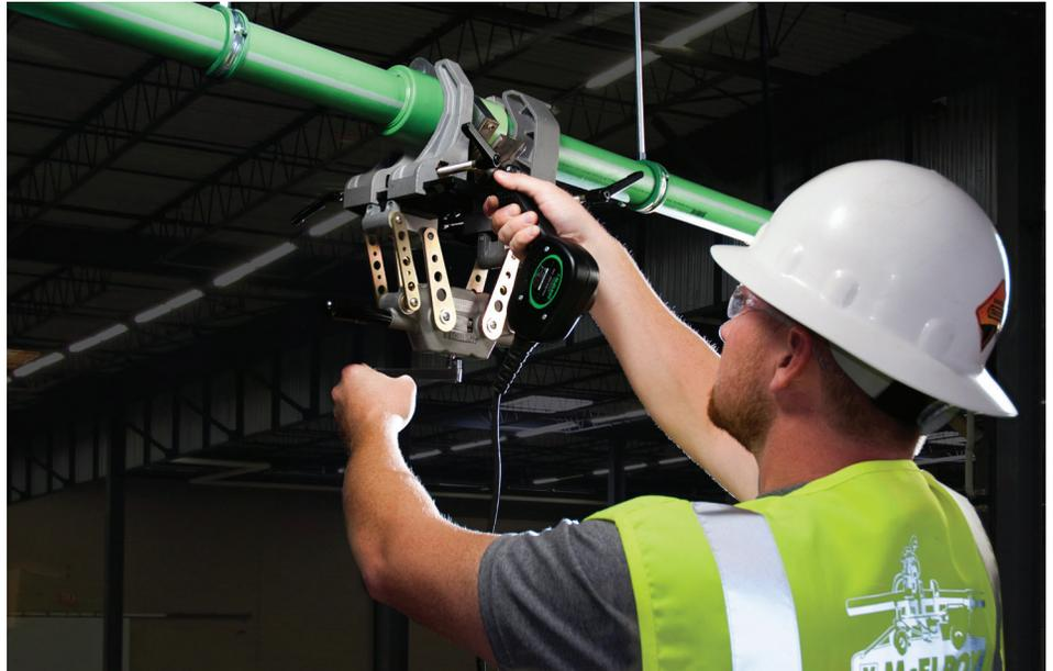
**Figura 5-1: Realizar conexiones PP-RCT superiores**
