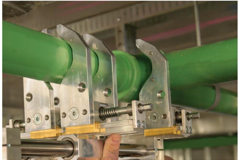
**Figura 2-6: Fusión de encaje con el uso de una plantilla**
