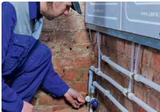
Exemplu: Conectarea panourilor Uponor Renovis cu fixare pe perete. Control încăpere individuală cu termostat de cameră
