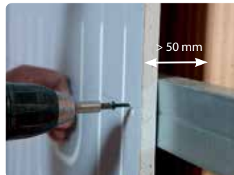
Substructură cu profile metalice CD 27/60
