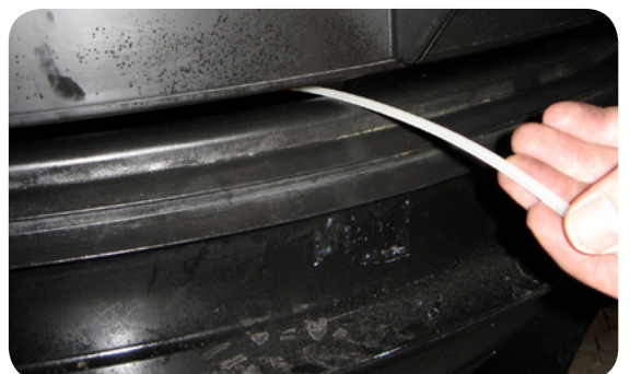
Undgå loftlomme ved brug af kabelbinder
