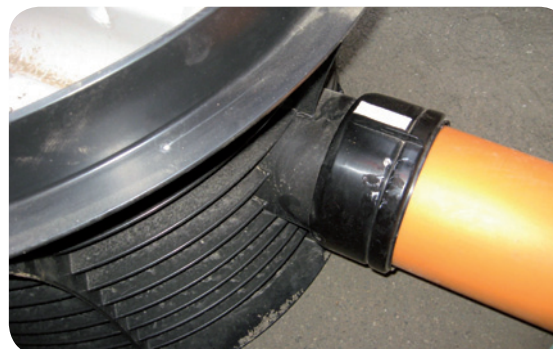
Rør monteret i muffe
