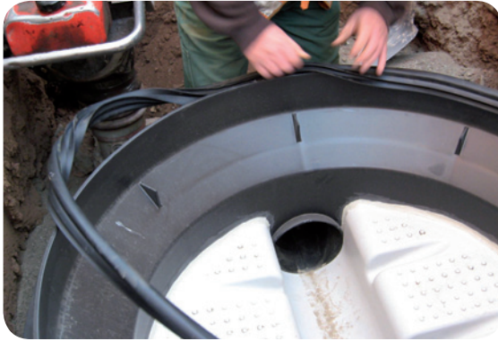
Montering af tætningsring
