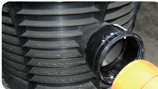
Montering af rør
