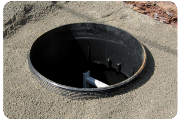
Opkomprimering af kegle
