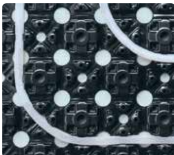
Țevă PE-Xa instalată în unghi de 90°
